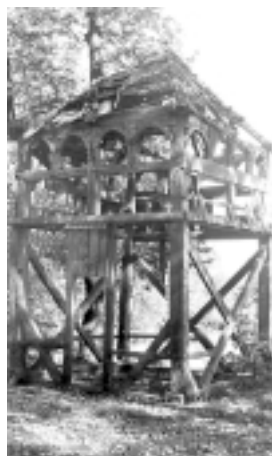
Zniszczona, nieistniejąca dziś dzwonnica cerkwi, stan z 1964 roku
