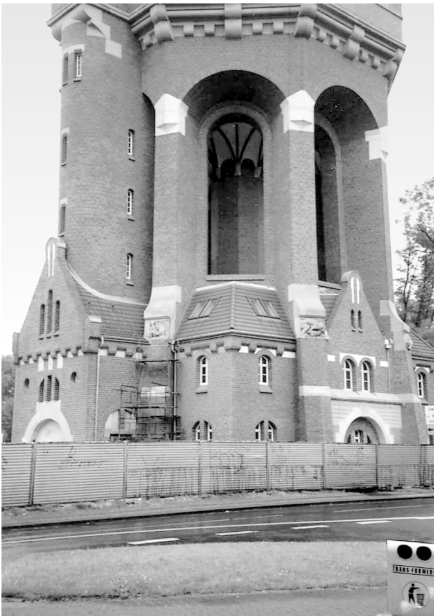
Rys. 3. Wierzchnia warstwa w spoinach pokazanej budowli wykonywana była z zaprawy cementowej o innym składzie niż zaprawa wewnątrz muru i była skarbonizowana
