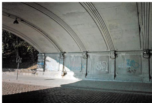
Fot. 3. Widok sklepienia wewnątrz arkad wiaduktu
