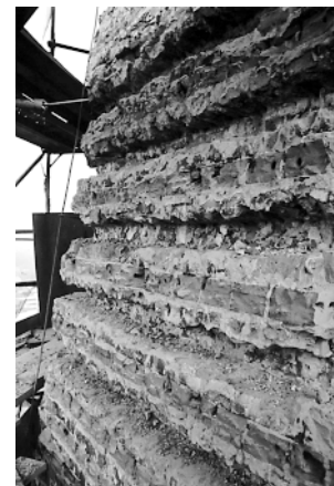
Rys. 13. Pierwszy etap renowacji – usunięcie zniszczonej warstwy licowej
