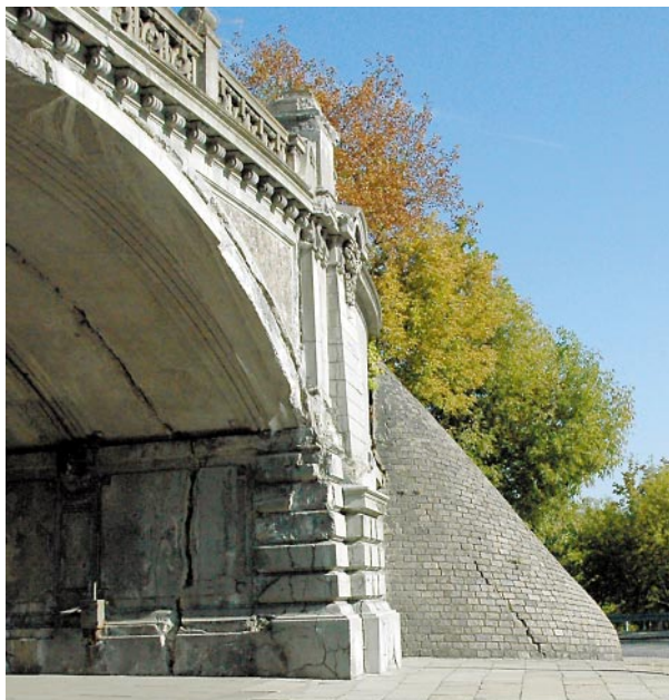
Fot. 7. Widok przyczółka wschodniego
