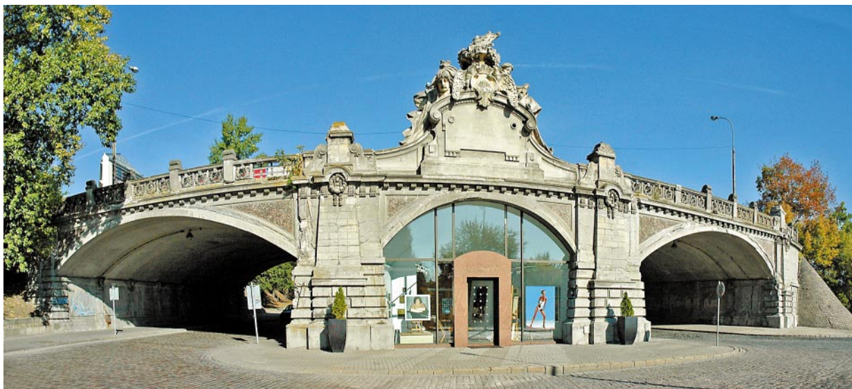
Fot. 1. Widok ogólny wiaduktu im. S. Markiewicza
