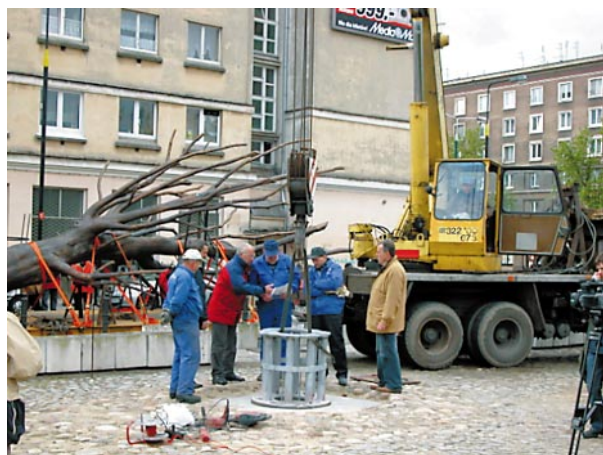
Pawiak, prace przy posadwieniu Drzewa
