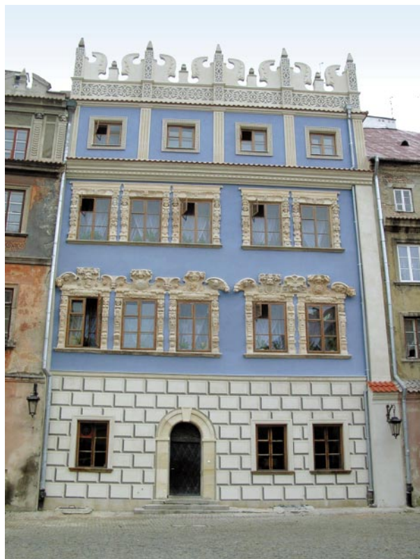
Lublin, fragment kamieniarskiego wystroju elewacji frontowej kamienicy przy Rynku 12 w Lublinie
