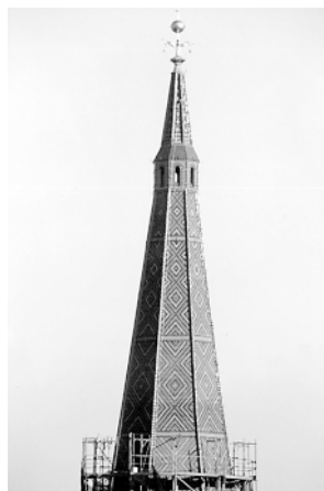
Rys. 18. Hełm wieży po renowacji
