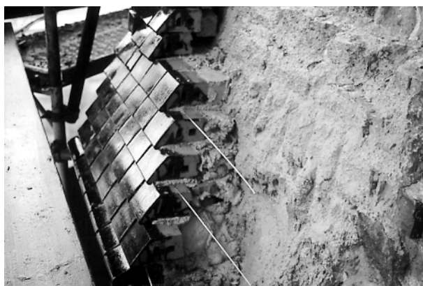
Rys. 15. Murowanie kolejnych warstw licówki, zbrojonej co drugą spoinę wsporną
