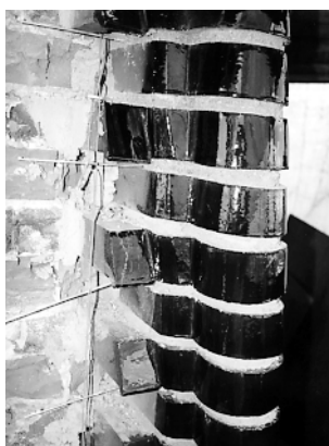
Rys. 14. Murowanie elementów narożnych
