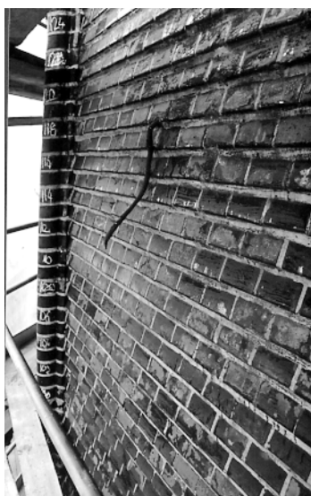
Rys. 7. Powierzchnia hełmu pokryta czarnym nalotem sadzy
