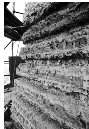
Rys. 13. Pierwszy etap renowacji – usunięcie zniszczonej warstwy licowej
