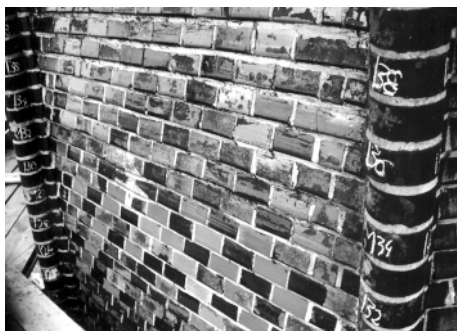
Rys. 9. Oczyszczona powierzchnia najmniej uszkodzonej północno-wschodniej połaci helmu
