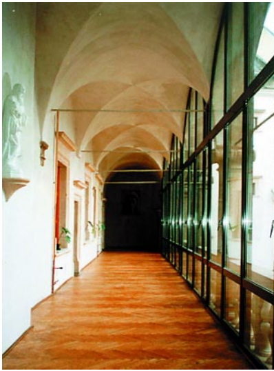
Nowa ściana osłonowa na piętrze, umożliwiająca pełną ekspozycję arkad. Fot. W. Klag
