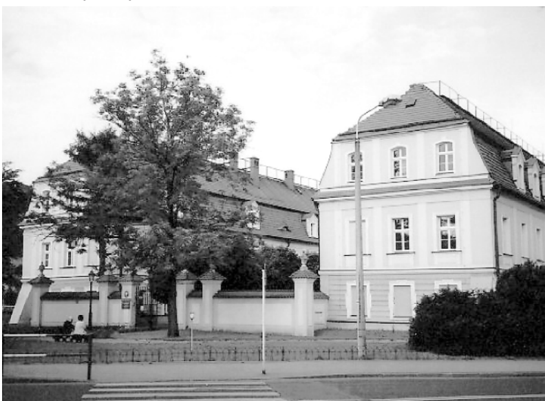
Rys. 9. Widok skrzydeł bocznych zamku od strony wschodniej
