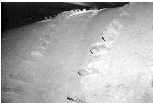
Fot. 11. Fragment oczyszczonej strony grzbietowej sklepienia
