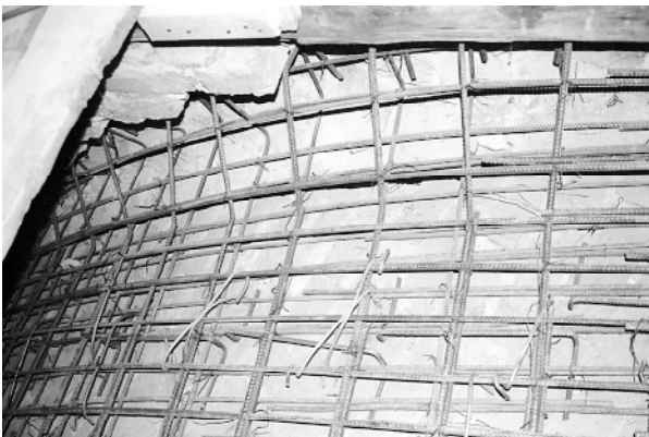
Fot. 24. Szczegół zbrojenia podwójnego w rejonie wieńca podporowego
