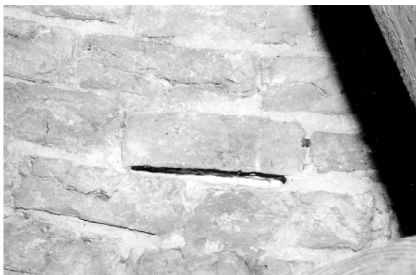
Fot. 12. Wysoka spoina między cegłami przeznaczona do osadzenia kotwy
