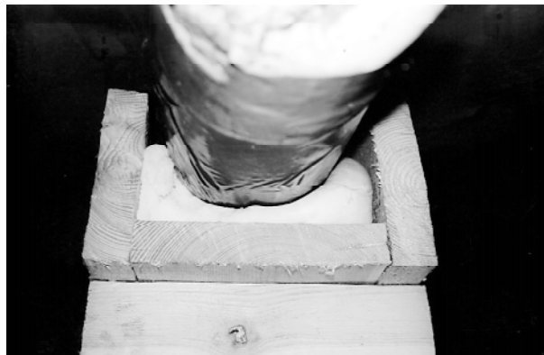
Fot. 4. Poduszka z pianki poliuretanowej pod żebrzem sklepienia
