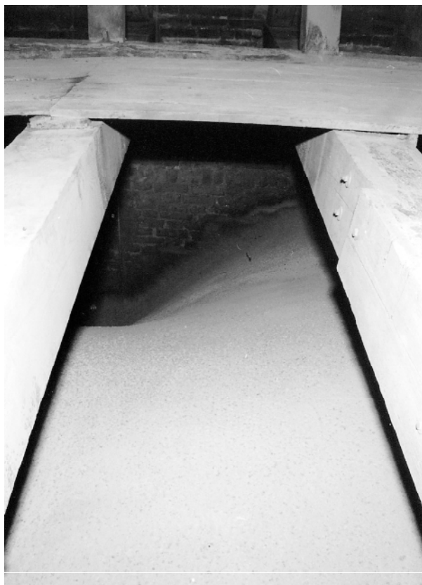
Fot. 33. Fragment sklepienia po zakończeniu prac
