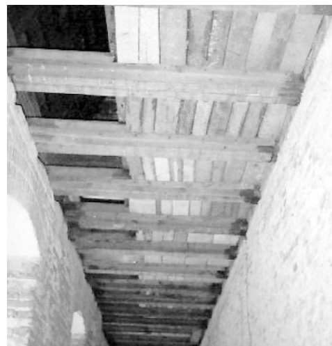
Rys. 5. Odślonięte belki stropu drewnianego nad korytarzem
