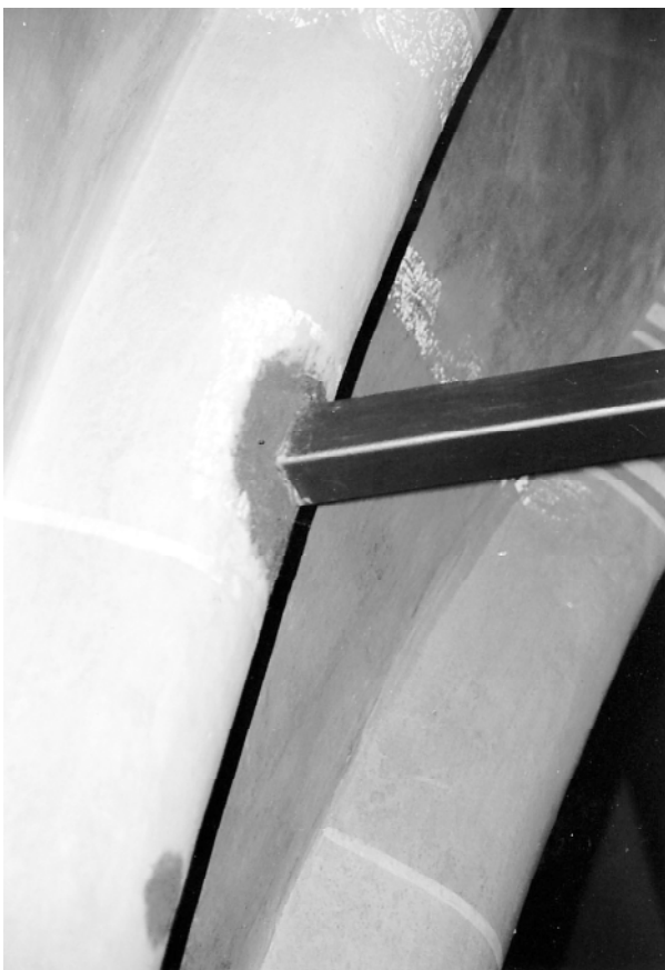
Fot. 9. Fragment wykonanego ściągu
