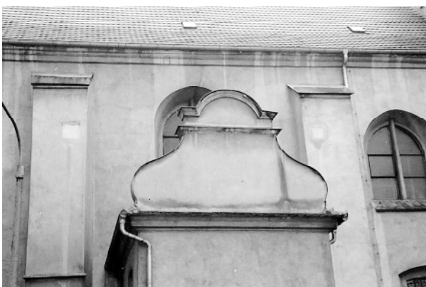
Fot. 8. Miejsca kotwienia ściągów w przyporach
