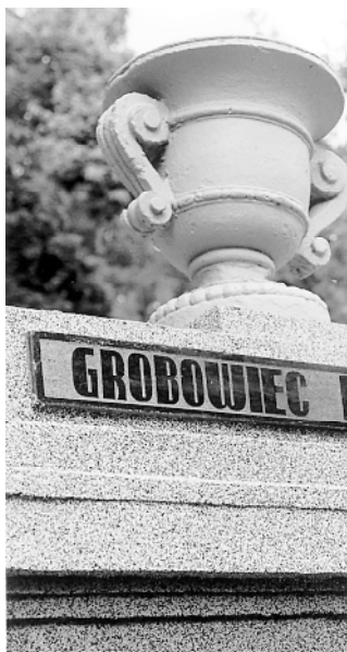
Grobowiec Bystrzyckich, poł. XX w.; grobowiec pokryty tynkiem natryskowym, waza pomalowana w kolorze popielatym; kwatery 27b
