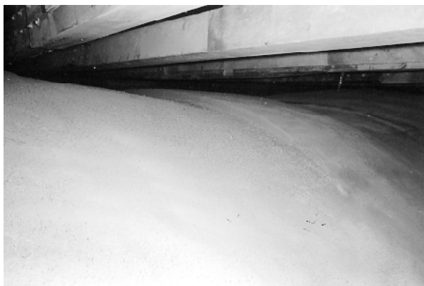
Fot. 32. Widok na żebro poprzeczne po zakończeniu prac
