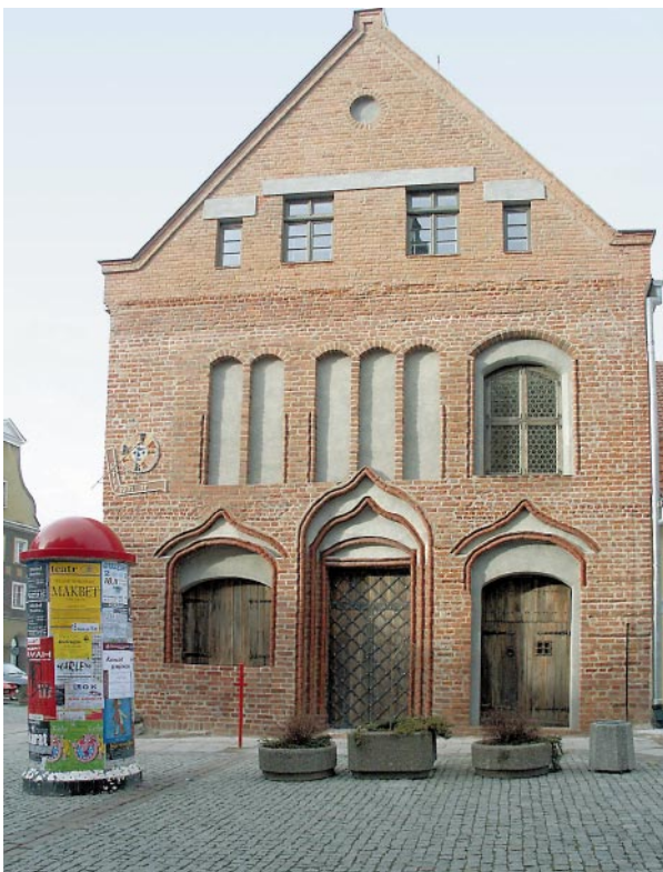
Olsztyn, Stary Ratusz, widok na elewację południową po zakończeniu prac konserwatorskich prowadzonych przez firmę Konserwatorską Piotr Biało, Zabytki Malarstwa, Rzeźby Architektury Spółka z o.o. Kraków. Stan z 15 listopada 2003 r. Fot. K. Sobaczewski
