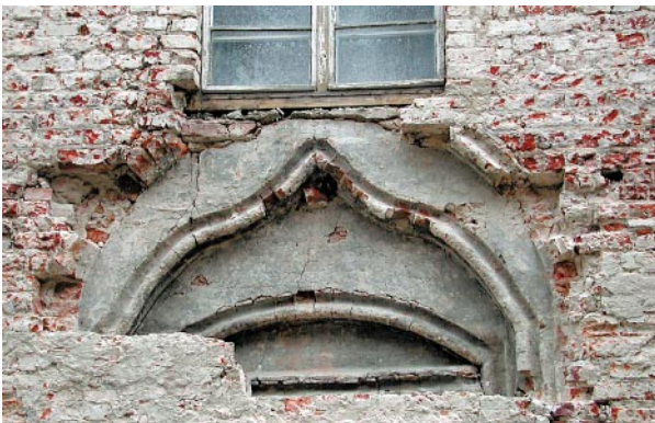
Olsztyn, Stary Ratusz, elewacja wschodnia, po usunięciu zamurowania ukazało się zwieńczenie portalu z cegły kształtki w „ośli grzbiet”. Stan z sierpnia 2002 r. Fot. K. Sobaczewski
