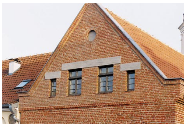
Szczyt elewacji zachodniej po konserwacji
