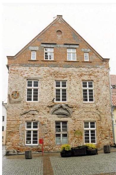
Elewacja wschodnia Ratusza przed konserwacją
