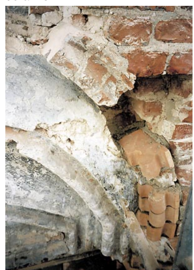
Wypełnianie ubytków w profilach obramień
