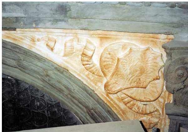
Fragment żagielka okna tamburu. Założono kompres li-gninowy odsączający pokost ze struktury kamienia
