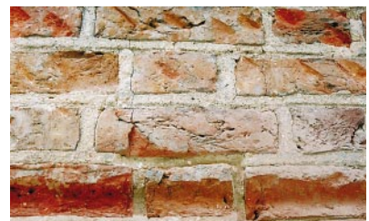
Trójkątne podcięte fugi w wątku gotyckim
