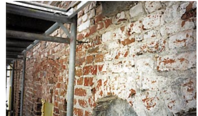
Zabrudzenia powierzchni wątków ceglanych i ich usuwanie
