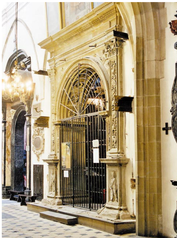
Portal kaplicy po zdemontowaniu zabytkowych krat metalowych. Widoczna na fotografii krata stanowi tymczasowe zamknięcie kaplicy
