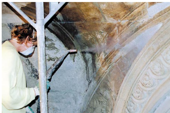
Doczyszczanie powierzchni kamienia parą wodną
