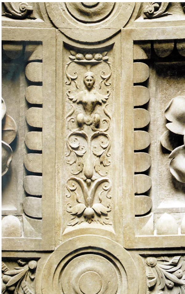
Fragment kopuły po konserwacji. Widoczny całkowicie zrekonstruowany ornament groteskowy w masie sztucznego kamienia
