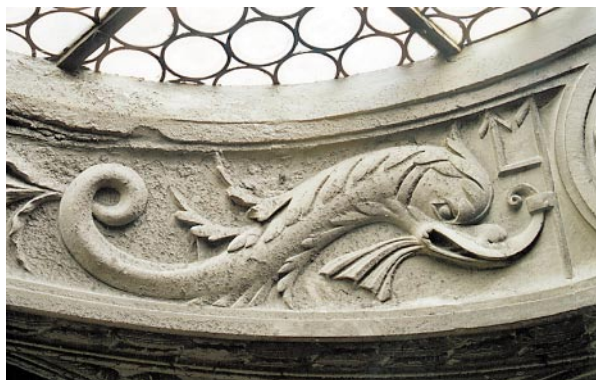
Delfin z węgara okrągłego tamburu. Dezintegracja ziarnista powierzchni
