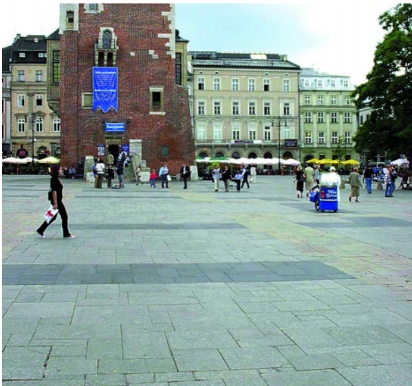
Stan nawierzchni w zachodniej części Rynku Głównego przed remontem, koniec 2003 roku
