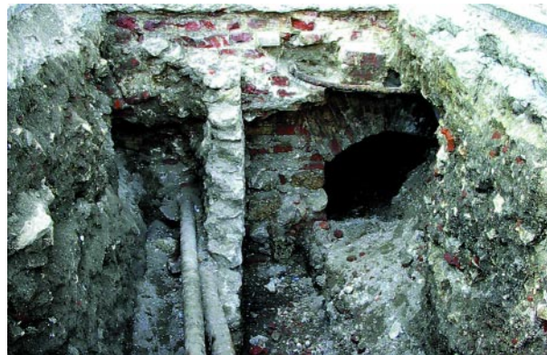
Wykop w rejonie północno-wschodniego narożnika Sukiennic wykonany w 2003 roku z widocznym murem fundamentowym arkad i reliktem wtórnej ściany działowej kramów (fot. autor)
