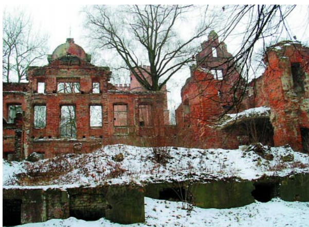
Fot. 2. Widok pałacu od strony wschodniej
