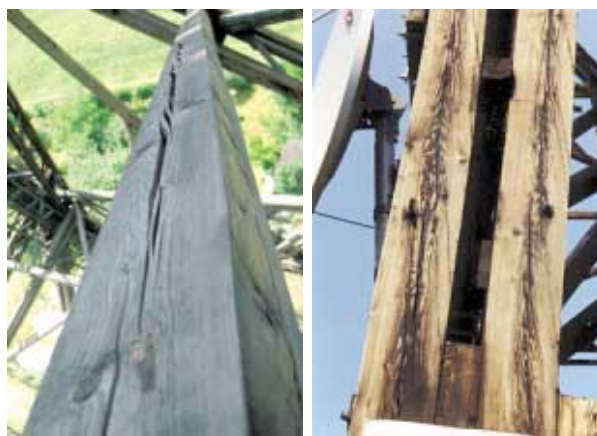
Rys. 4. Spękania podłużne prętów
