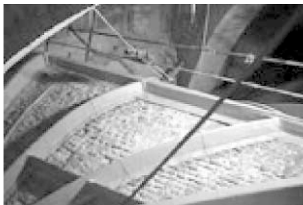
Rys. 16, 17. Zastosowanie grzbietowych, drewnianych żeber wzmocniających ceglane sklepienie w bazylice św. Franciszka w Asyżu
