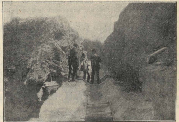
Rys. 49. Schönau. Podłoże betonowe pod przepust górny (rury żelazne).
