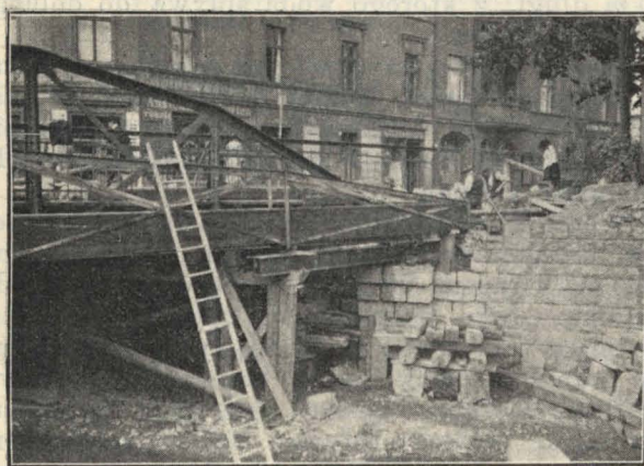
Rys. 15. Bobrawa, Landeshut. Powiększenie światła mostu.
