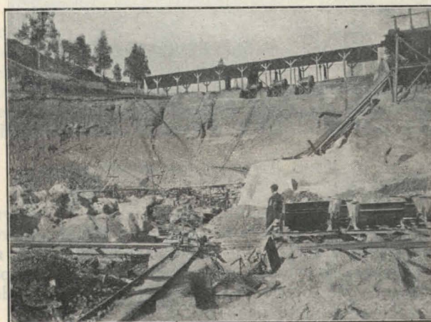
Rys. 10. Betonowanie podłoża pod zaporę obok Mauer na Bobrawie.
