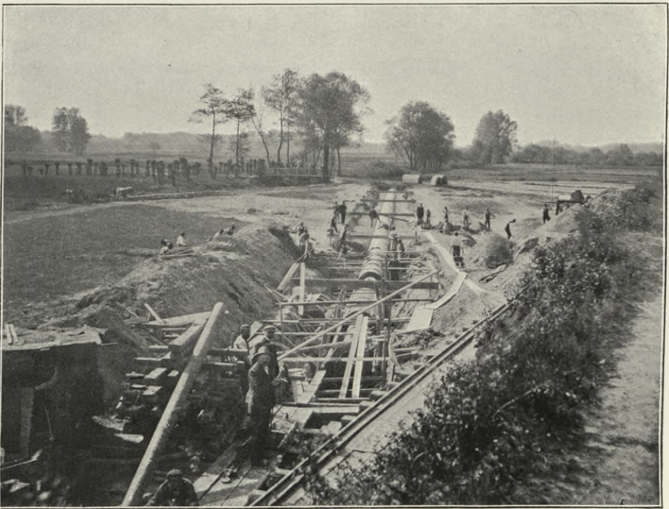
Nr. 17. Unterführung des Hořiner Baches unter den Schiffahrtskanal bei Hořín am 31. Mai 1902.
