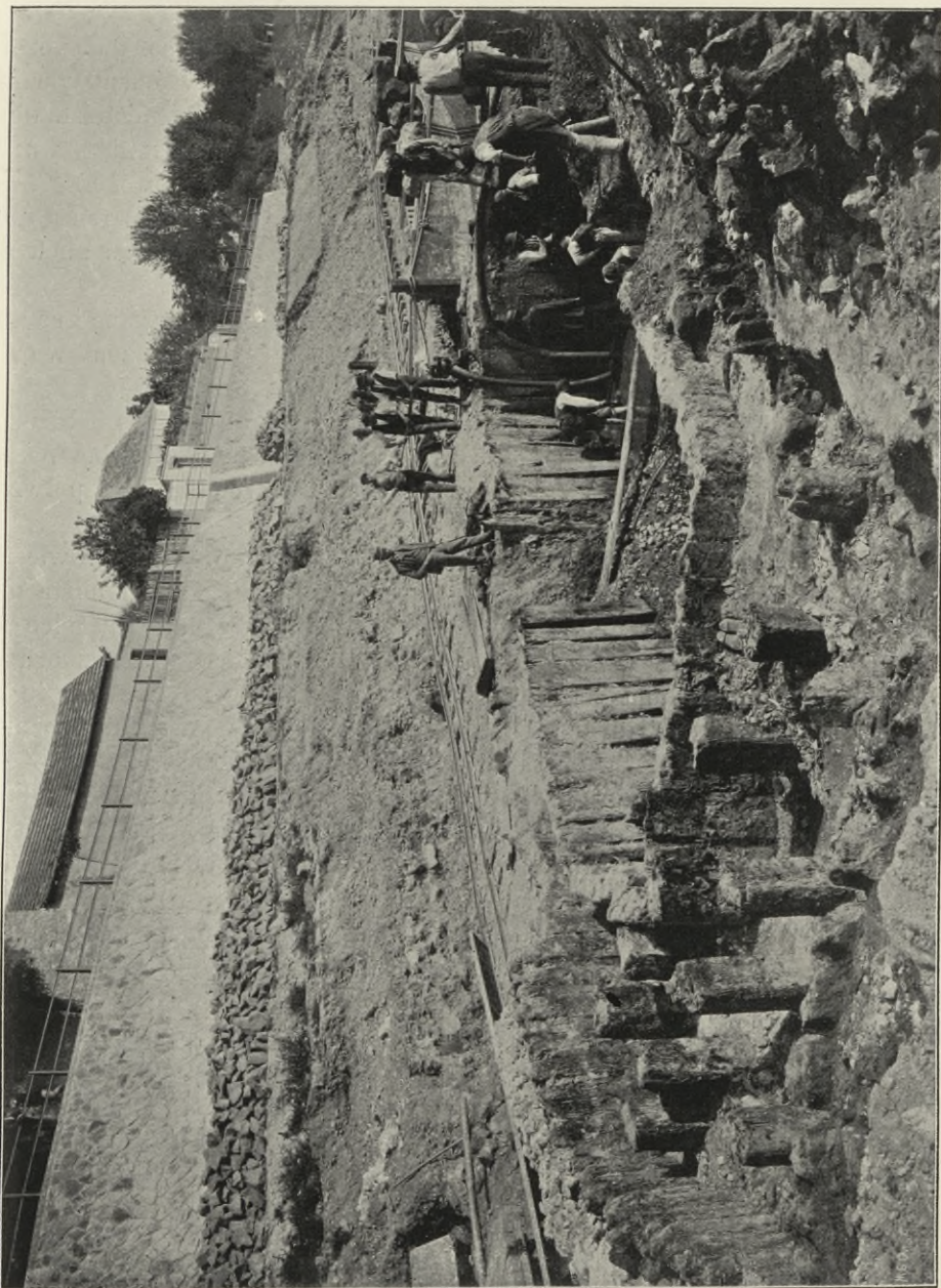
Nr. 10. Aufgedeckte Fundamente eines Mittelpfeilers der bestehenden Brücke bei Mirowic am 4. September 1902.
