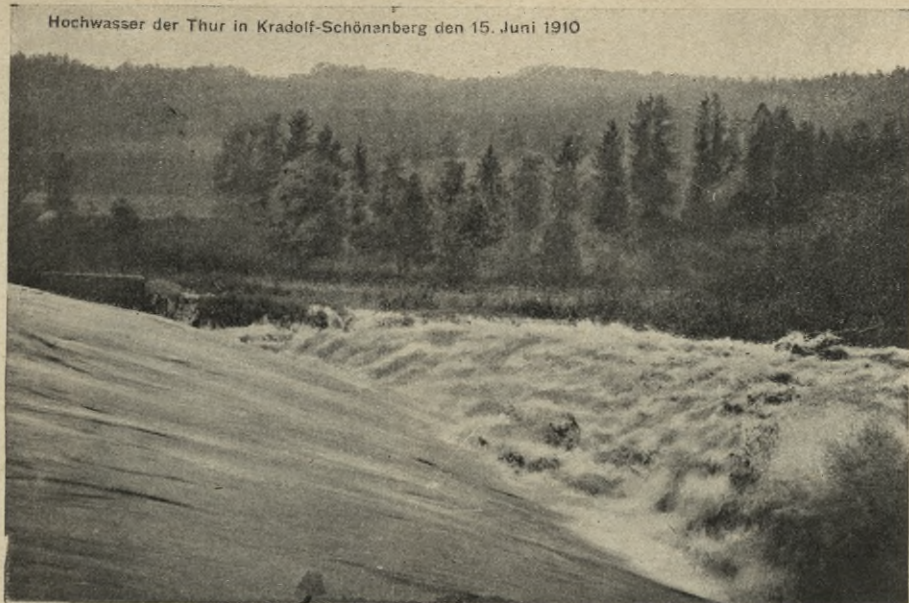
Abbildung 31. Hochwasser der Thur in Kradolf-Schönenberg, Wehranlage.
