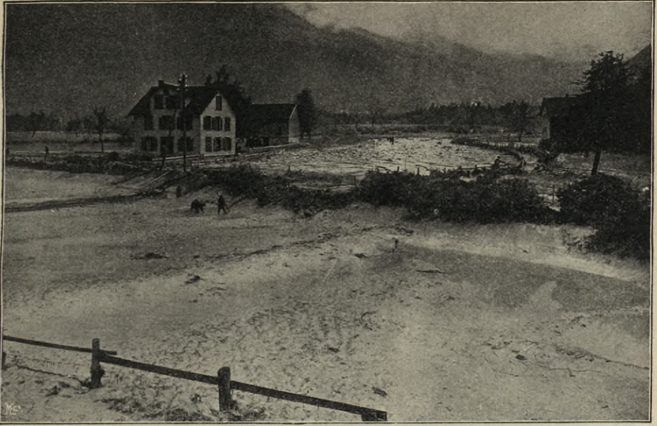
Abbildung 46. Hochwasser des Schächen. — Verheerungen rechts vom Schächen. Ein neuer Flussarm. Verschlammte Wiesen.
