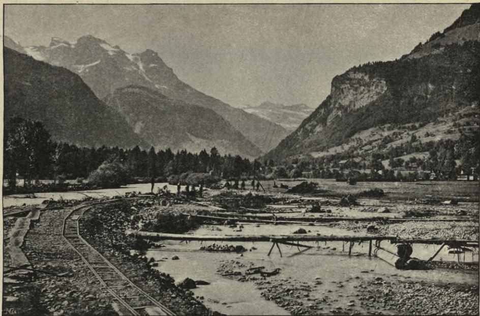
Abbildung 55. Der fertige Notdamm.
