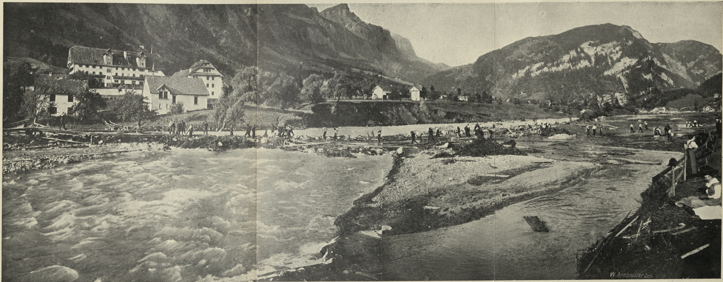
Abbildung 49. Dambruch gegenüber Frauenkloster, Durchbruchstelle unter Mithilfe des Militärs wieder abgeschlossen. Aufnahme vom 22. Juni 1910.
