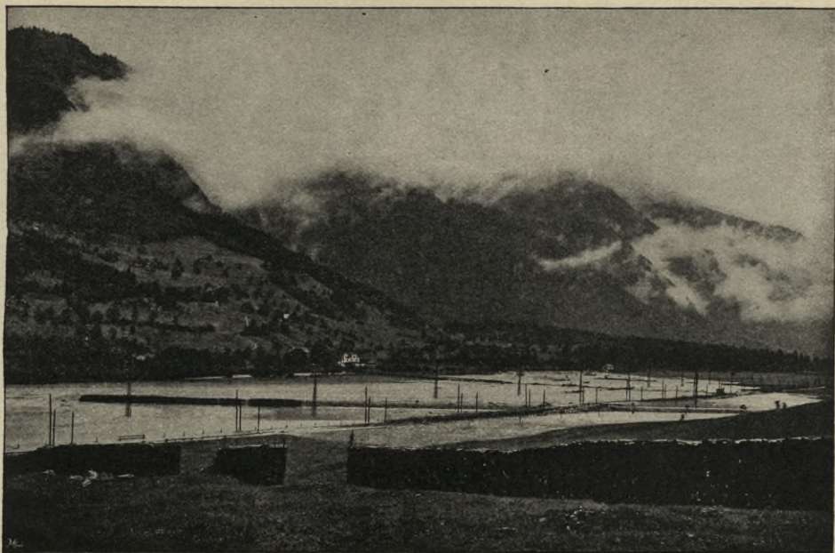
Abbildung 53. Dambruch der Aa zwischen Dallenwil und Büren und die überflutete Allmeind.
