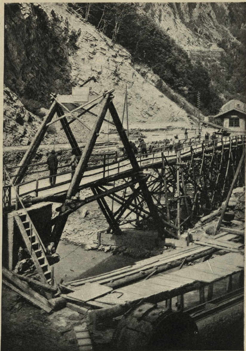
Abbildung 23. Teil der durch Genietruppen erbauten Brücke bei Felsenbach (Prättigau).
