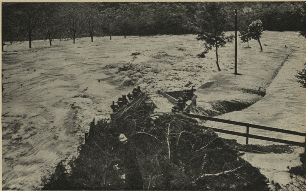
Abbildung 67. Der Wogenanprall bei der Stelle, wo die Mühlfuhrbrücke weggerissen wurde.
