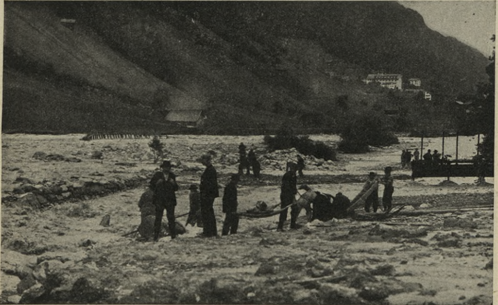
Abbildung 61. Das durch die Rufiruns verschüttete Linthbett u. die zerstörte Eisenbahnlinie bei Adlenbach.
