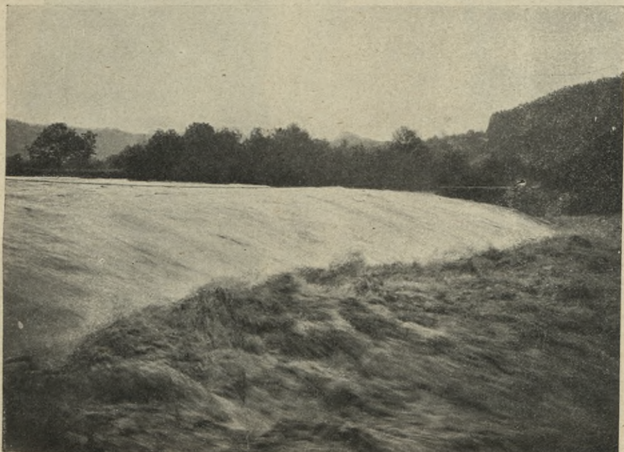
Abbildung 32. Hochwasser der Thur in Kradolf-Schönenberg, Wehranlage.
