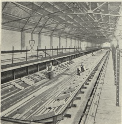
Fig. 35. Befestigung der Holzböschungen auf das Muldenprofil.
