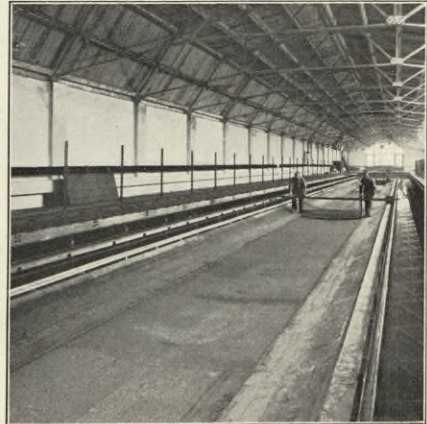
Fig. 36. Einebnung des zwischen den Holzböschungen befindlichen Sand-s in das gewünschte Kanalprofil.
