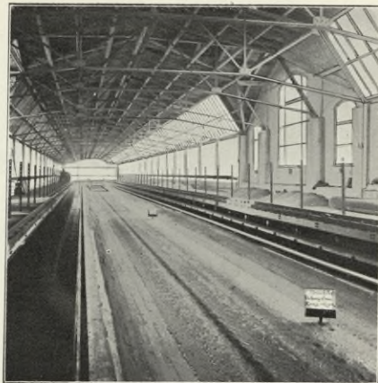
Fig. 57. Einwirkung der Schrauben auf die mit Kies bedeckte Sohle des Modells des Großschiffahrtsweges Berlin-Stettin nach 3510 Fahrten bei 808 Uml./min.
