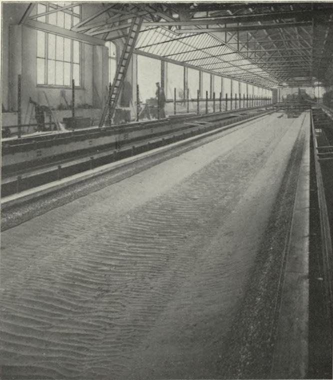
Fig. 73. Einwirkung der Doppelschraubenschiffe auf die Sohle des Modells des Rhein-Weser-Kanals nach 4000 Fahrten. Schrauben über oben nach außen schlagend.
