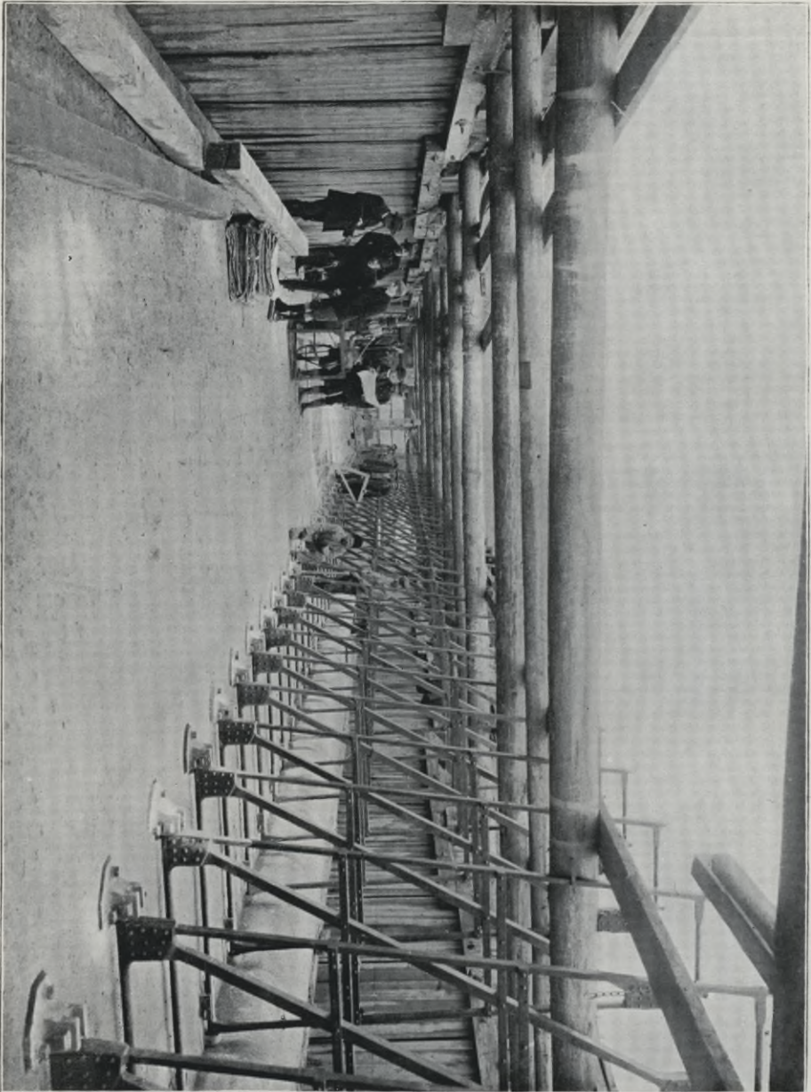
Nr. 26. Bau des Nadelwehres in Unter-Befkowie. (14. Dezember 1903.)
