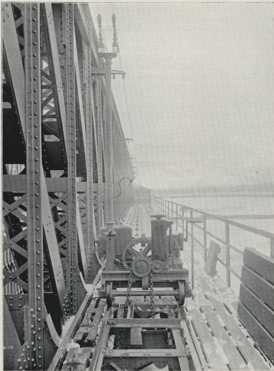
Nr. 10. Elektrische Winde zum Herausziehen der Schützen in Mirowie.
