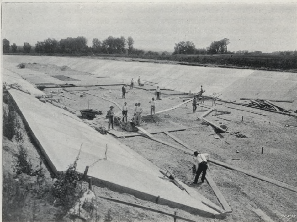
Nr. 15. Ausbetonieren des Lateralkanales Wraňan-Hořín. (18. Juli 1903.)
