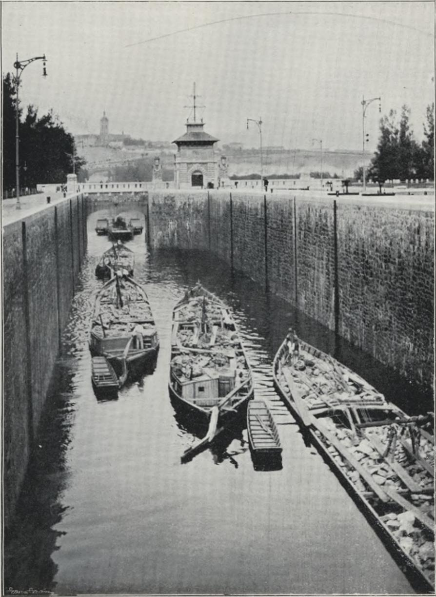
Abb. 10. Ausfahrt eines Schiffszuges aus der Zugschleuse in Hořín.
