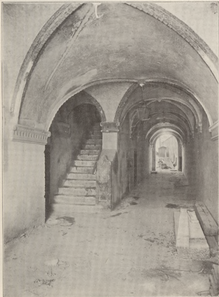
Sień w domu T-wa podczas robót restauracyjnych.
