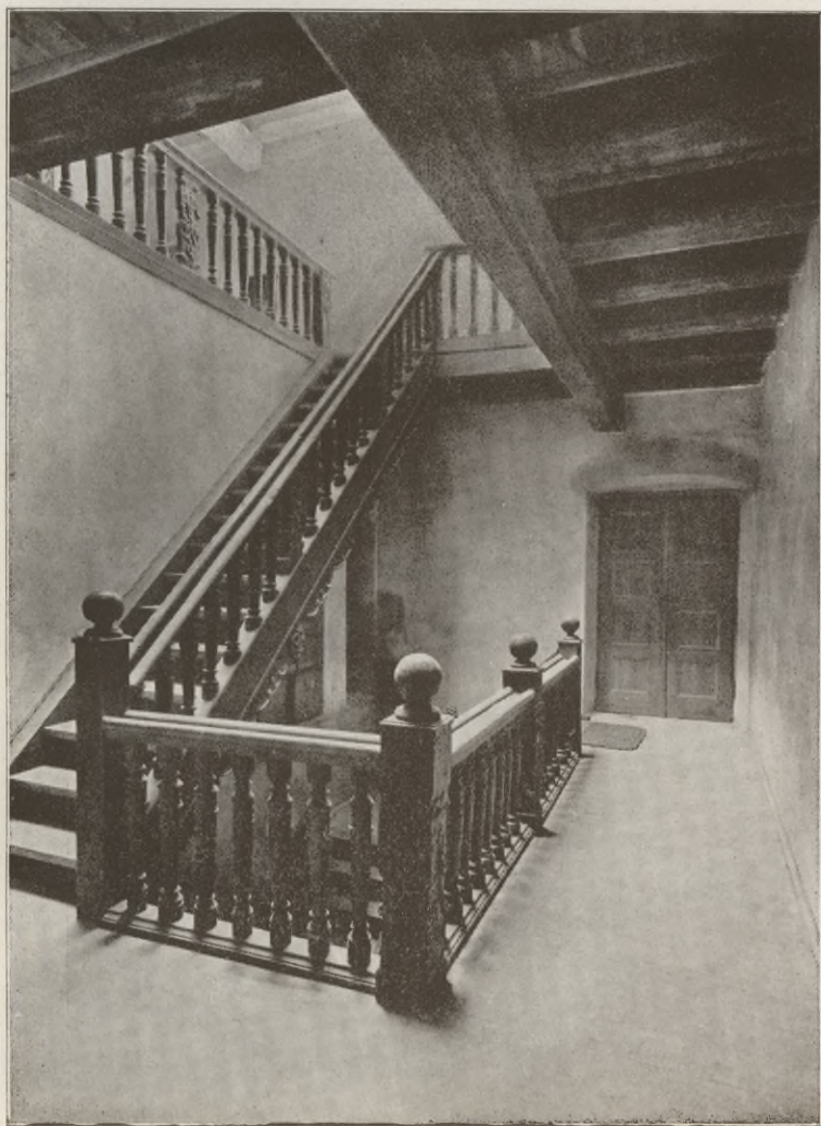
Klatka schodowa w domu T-wa.
