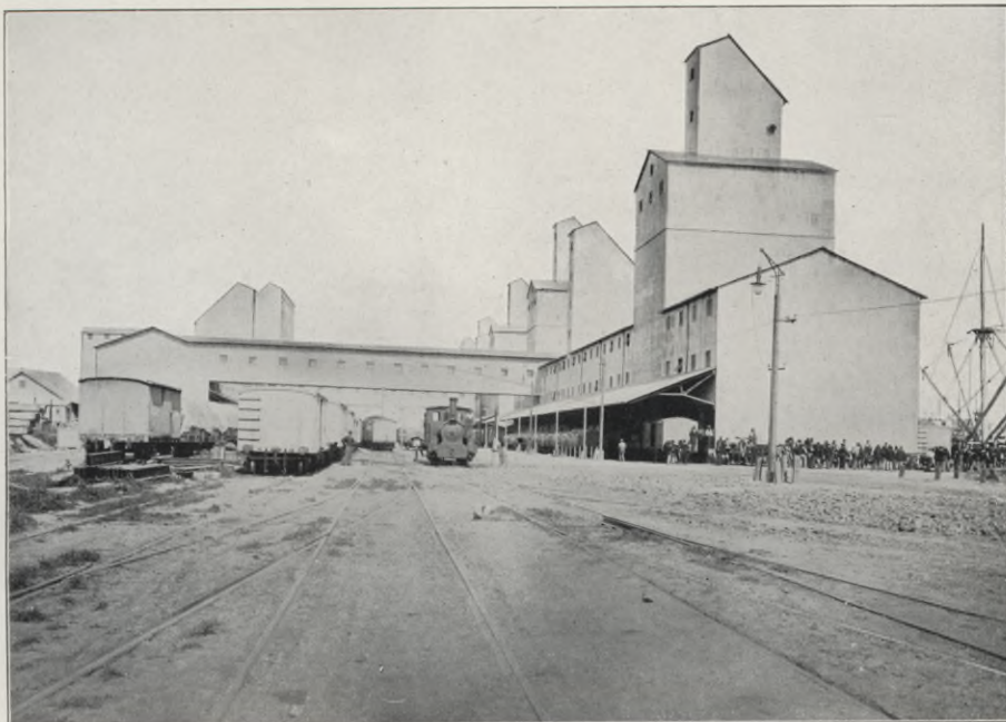
Abb. 94. Getreideelevatoren, Buenos Aires.
