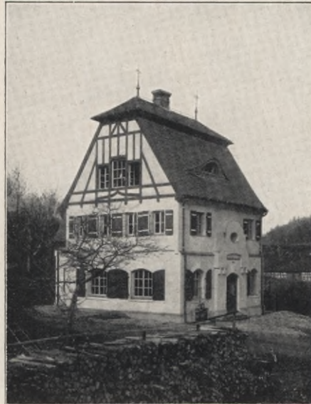
Kasberg-Gruppe, Maschinenhaus Nord-Ost-Ansicht.
