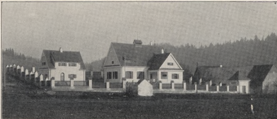
Maschinenhaus Viehausen-Bergmattinger-Gruppe Ansicht von Süden.
