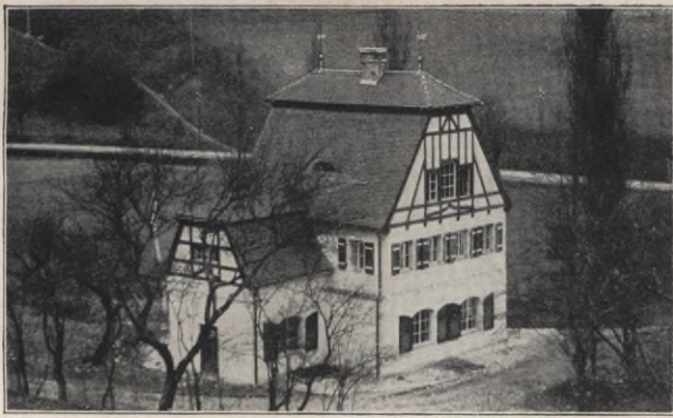
Kasberg-Gruppe, Maschinenhaus Nord-West-Ansicht.
