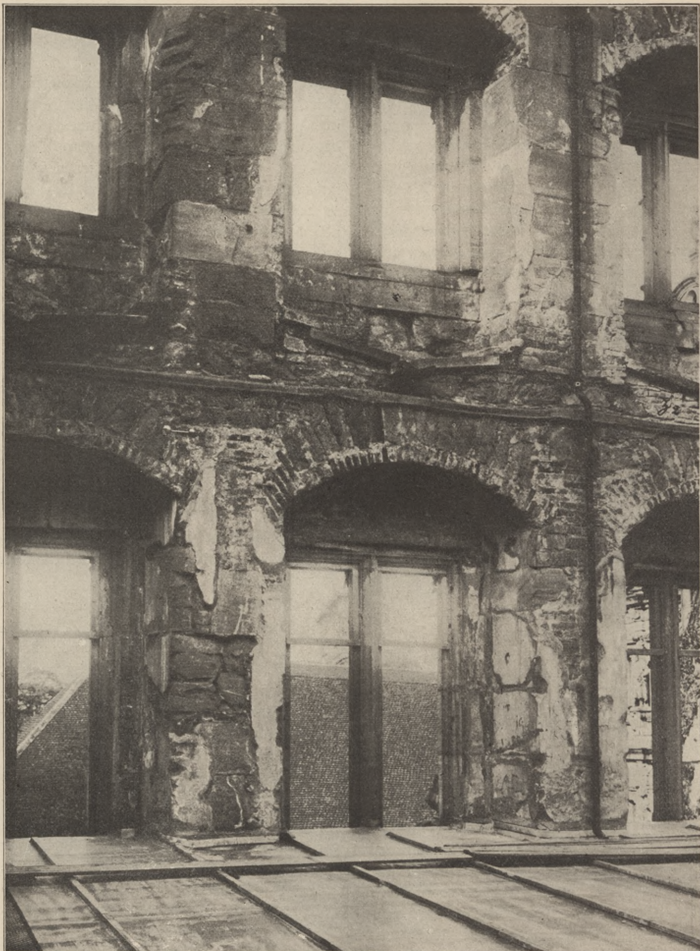
Fig. 33. Rückseite des 1. und 2. Obergeschosses über dem Zinkdach.
