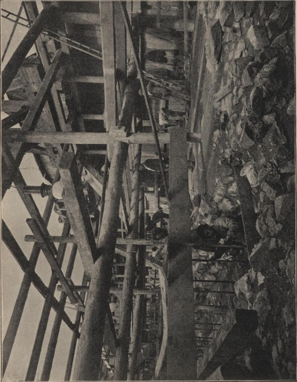
Fig. 9. Wehrbaugrube des I. Schützenwehrtheiles in Libschitz. Versetzung der Fundamentschrauben am 28. Juli 1899.
