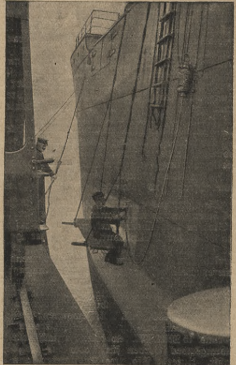
Abb. 2. Entrostungsmaschine beim Reinigen eines Schiffskörpers.
