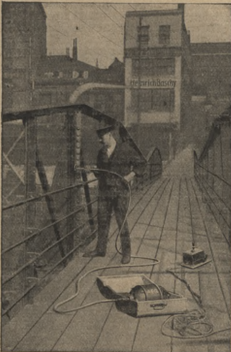
Abb. 1. Entrosten einer Brückenkonstruktion mit Hilfe der Entrostungsmaschine.
