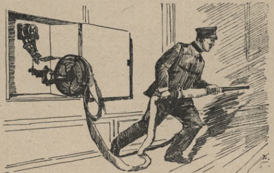
Abb. 3. Hydrant mit allseitig drehbarer Schlauchtrommel im Gange eines Passagierdampfers der Hamburg-Amerika-Linie.
