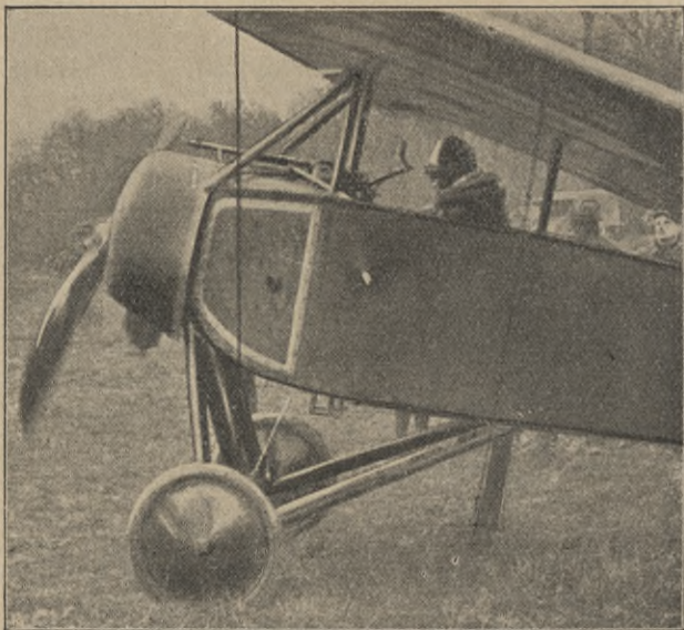
Abb. 2. Französischer Parasol-Morane-Saulnier-Eindecker vor dem Vorn ist das durch die Propellerbahn schießende Maschinengewehr mit dem Hebel zum Einschalten sichtbar.
