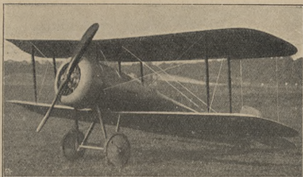
Abb. 3. Englischer 80 PS-Bristol-Doppeldecker mit rundem Rumpf.
