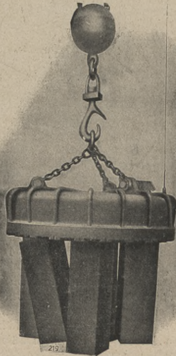
Abb. 2. Lastmagnet mit schweren Waßblöcken.
