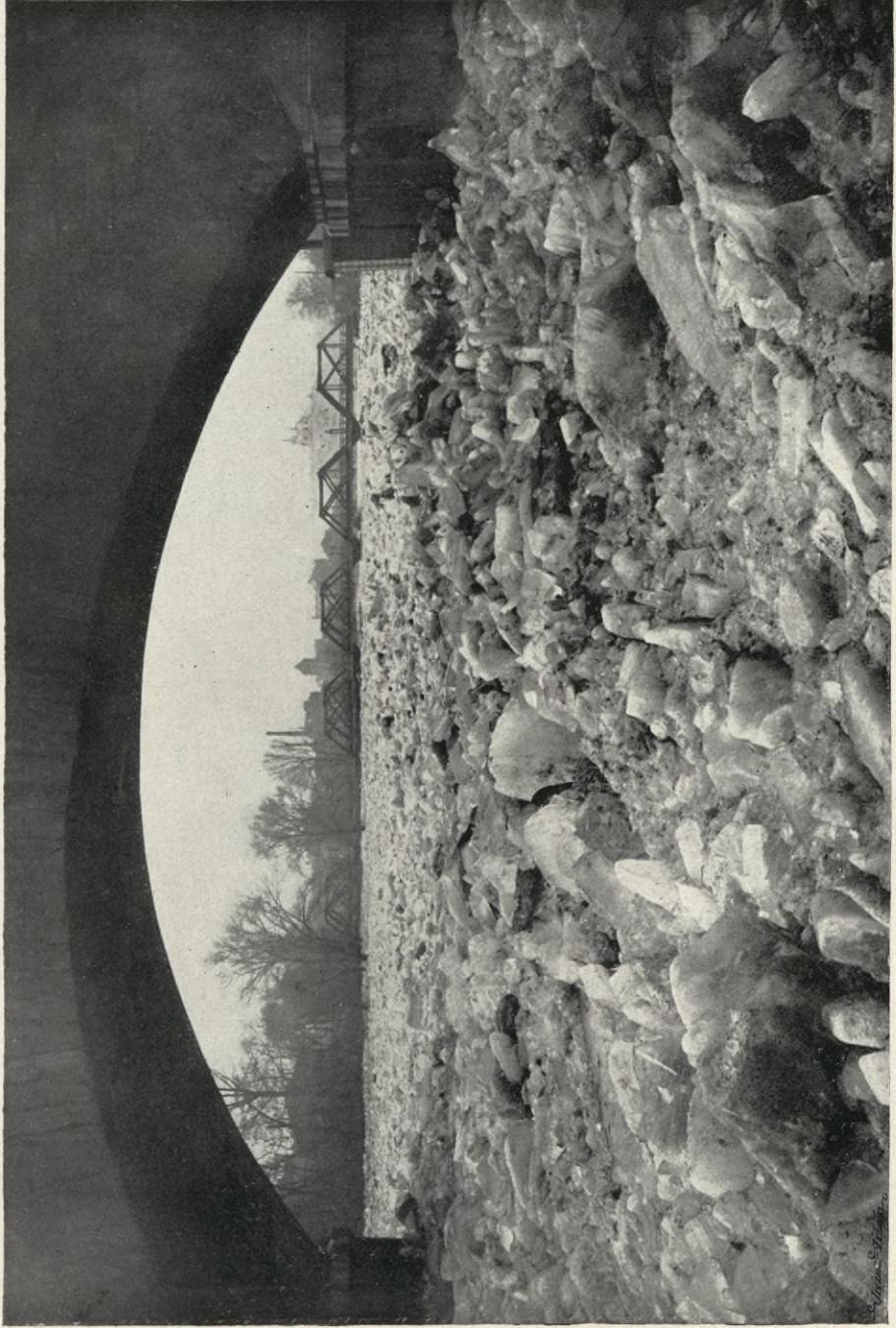
Abb. 18. Eisanschoppung im Hauptarm der Moldau beim Viadukte der St.-E.-G. in Prag am 4. Feber 1909.
