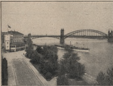
Abb. 4. Neue Straßenbrücke bei Bonn.
