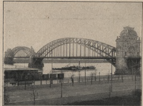
Abb. 5. Neue Straßenbrücke bei Düsseldorf.
