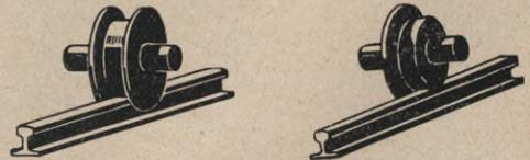
Abb. 3. Damit könnte man sicher fahren, wenn die Räder doppelte Spurkränze hätten, wie hier.
