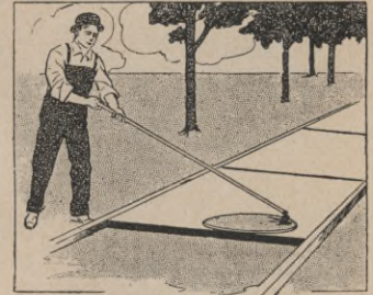
Abb. 9. Drehbare Stahlscheibe z. Glättung d. Betonbelags von Gehwegen.
