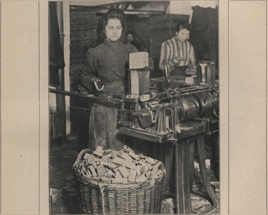
Abb. 7. Diese Maschine fertigt die Zündholzschachteln selbsttätig aus Holzspan an.
