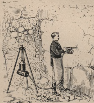
Abb. 6. Der Feinhammer als Bohrhämmer bei Bohr-arbeiten.
