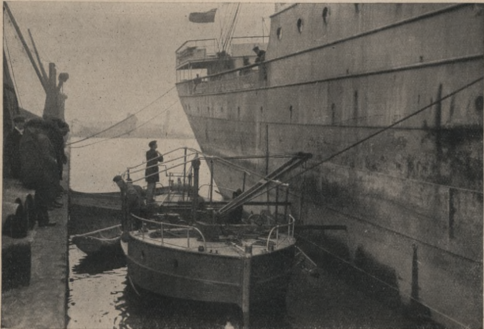
Abb. 1. Das den Reinigungsapparat tragende Motorboot legt sich neben das zu säubernde Schiff.
