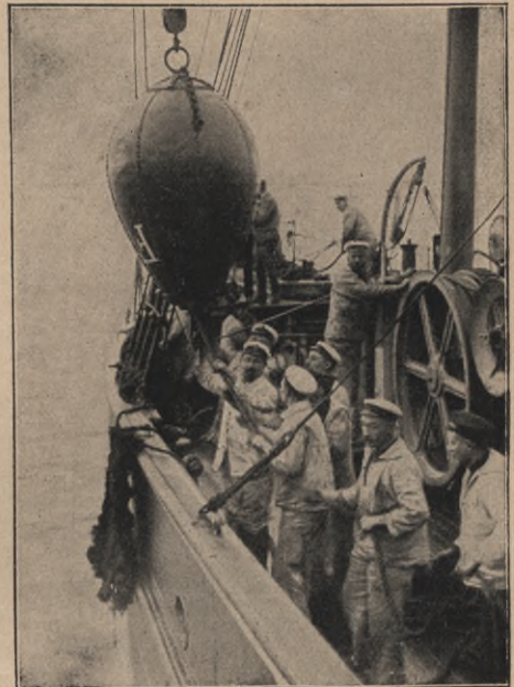
Abb. 5. Aussetzen einer Kabelboje.
