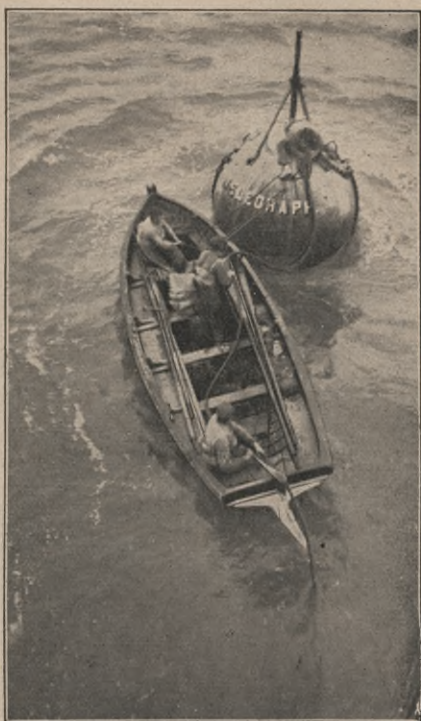
Abb. 6. Vorbereitung zum Aufnehmen einer Kabelboje.
