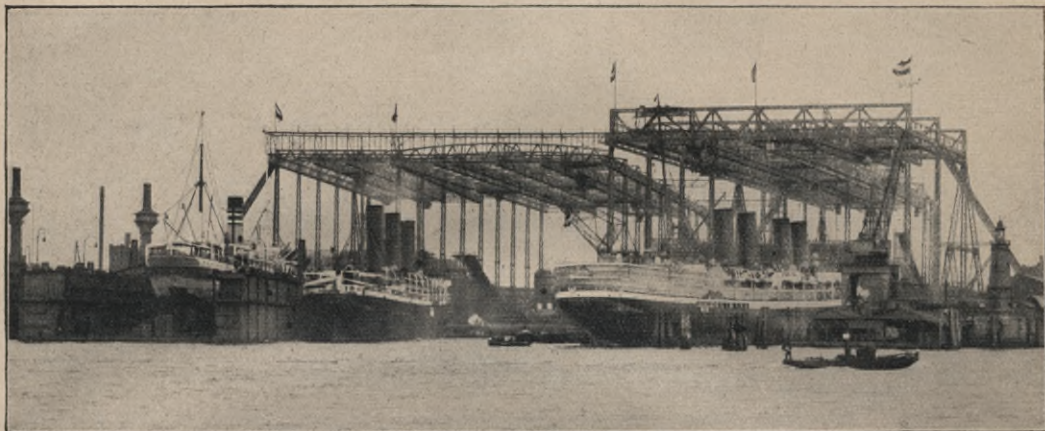
Abb. 3. Krangerüste der Werft von Blohm und Voß in Hamburg.
