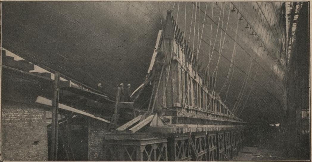
Abb. 1. Vorderschlitten des „Imperator“. (Vulkan-Werke, Hamburg.)
