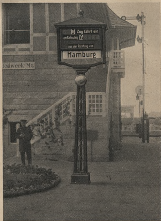
Abb. 5. Zugangsmelder auf der Internationalen Baufach-Ausstellung in Leipzig.
