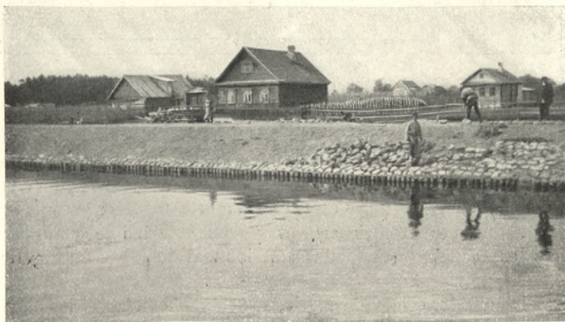
8. Canal Alexandre II; chemin de halage en construction.
