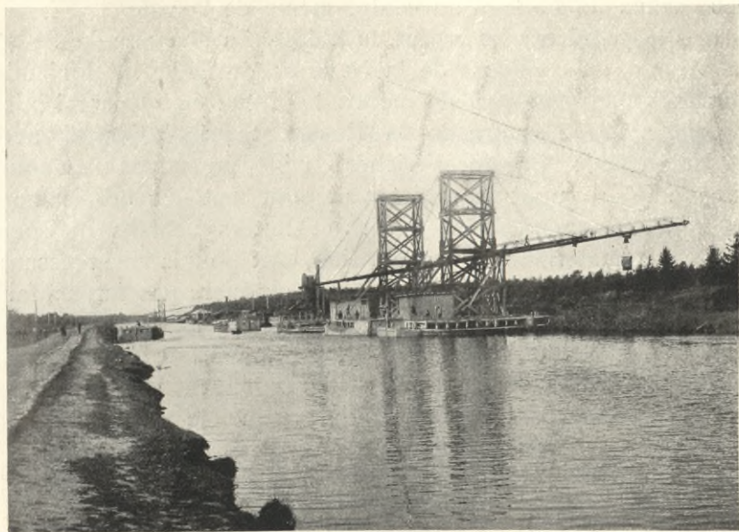
9. Canal Alexandre II; les machines à draguer.
