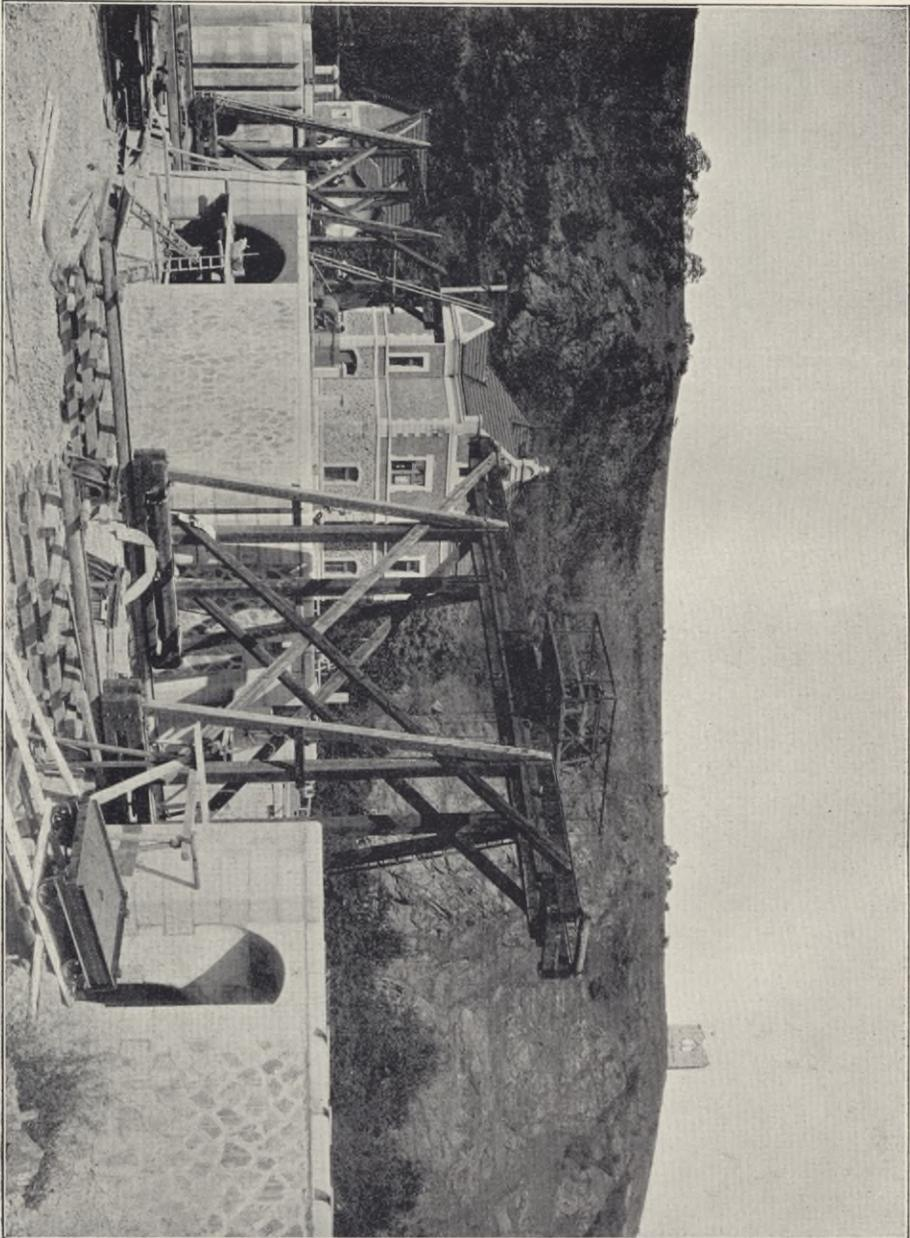
Fig. 11. Bau der Oberhäupter der Kammer- und Zugschleuse in Troja. Aufnahme am 28. August 1901.
