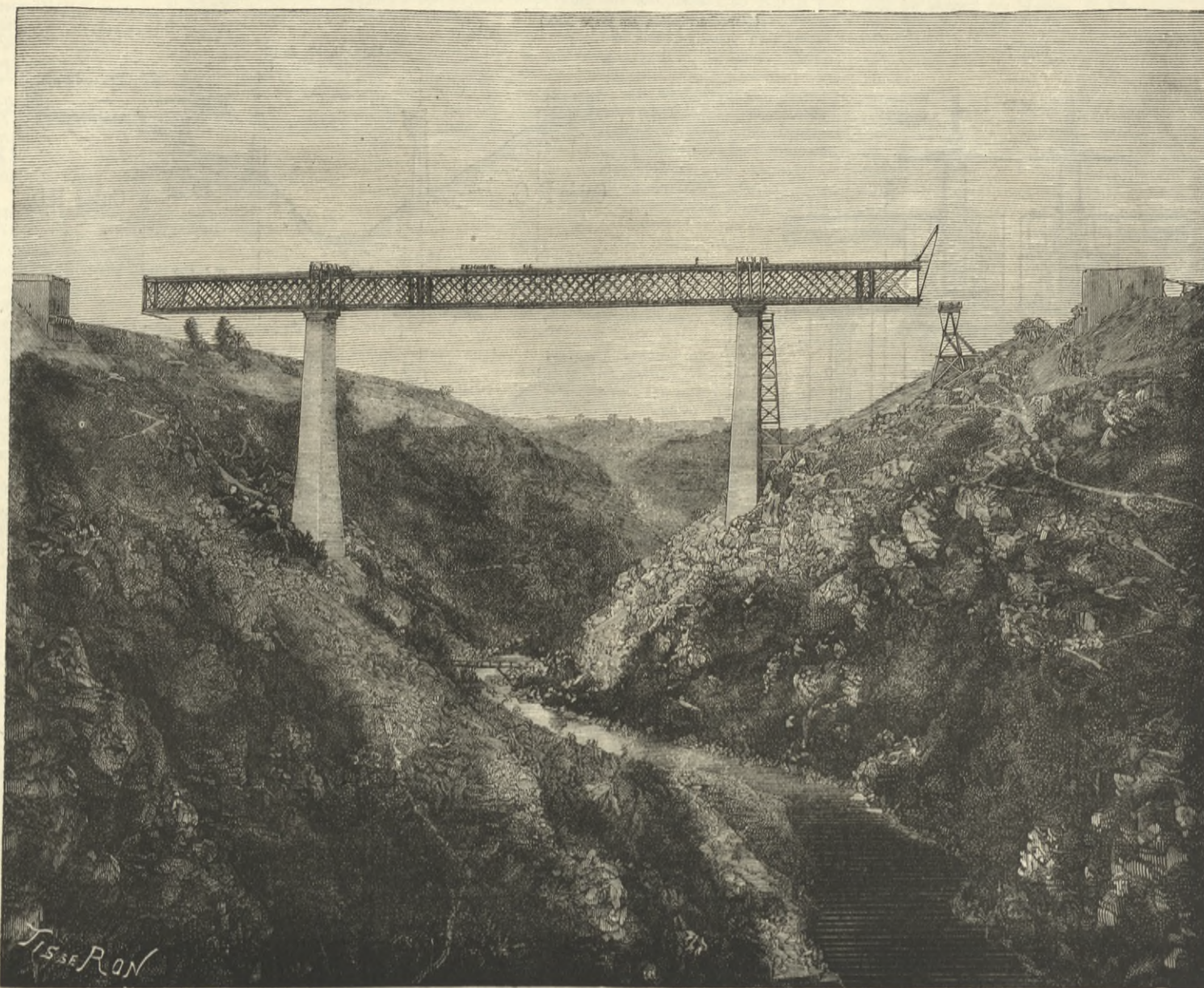
THE VIADUCT DE LA TARDES.
