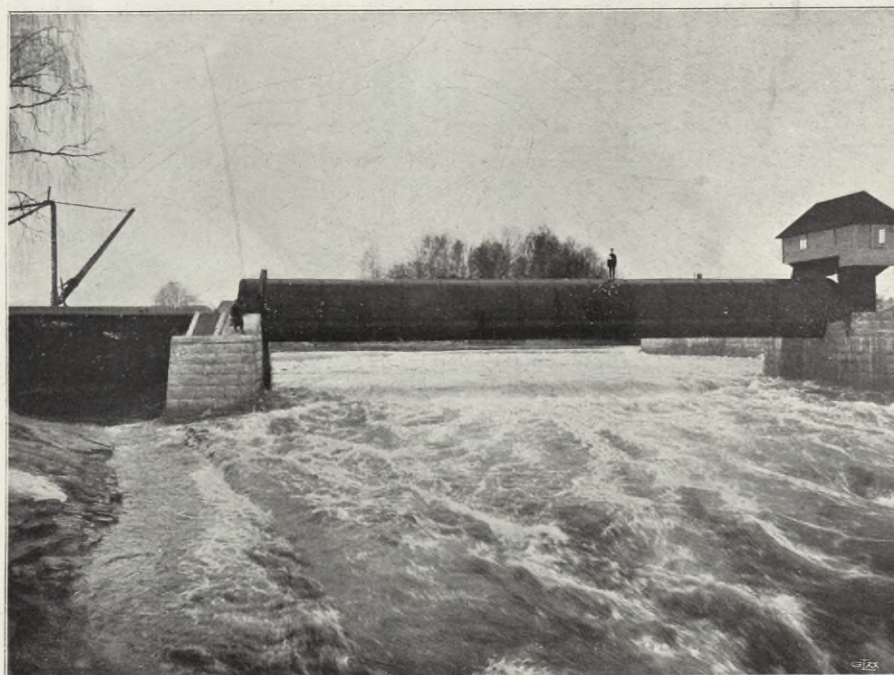
Fig. 35. Dejefors. Walzenwehr.
