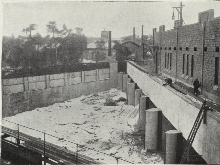
Fig. 27. Trollhättan, Das Verteilungsbecken entleert.
