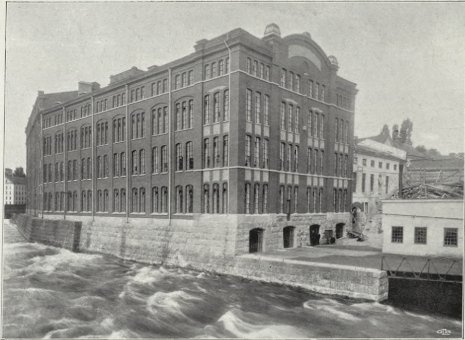
Fig. 71. Norrköping. Krafthaus und Fabrikgebäude der Bergsbro Aktiebolag.
