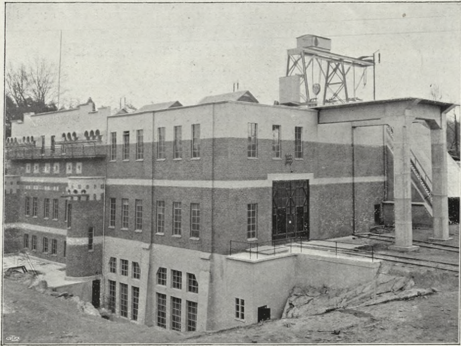
Fig. 40. Gullspång. Ansicht des Krafthauses.
