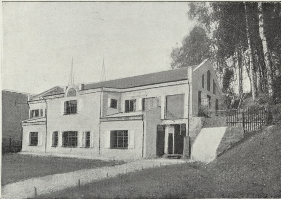
Fig. 34. Dejefors. Ansicht des Krafthauses.
