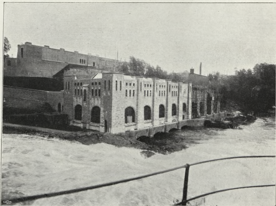
Fig. 28. Trollhättan, Ansicht des Krafthauses und der Druckkammern.
