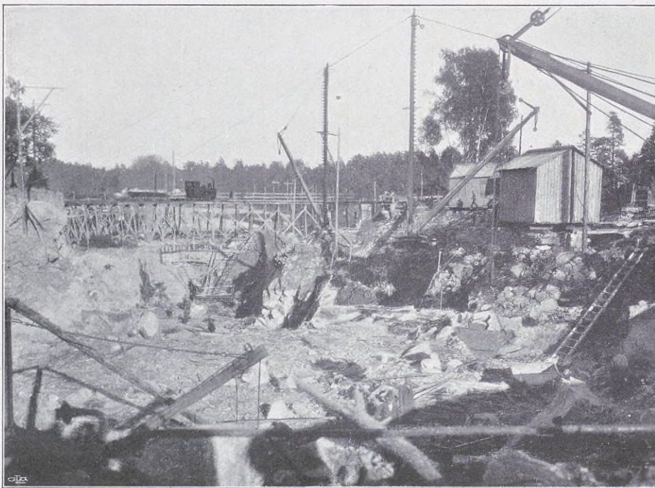
Fig. 18. Schakt för sluss vid Åkerssjö.
