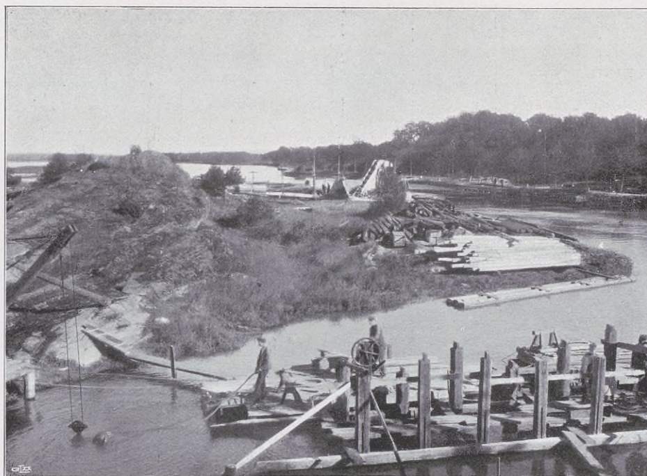
Fig. 13. Fångdammsbyggnad ofvan B. J:s bro vid Trollhättan.
