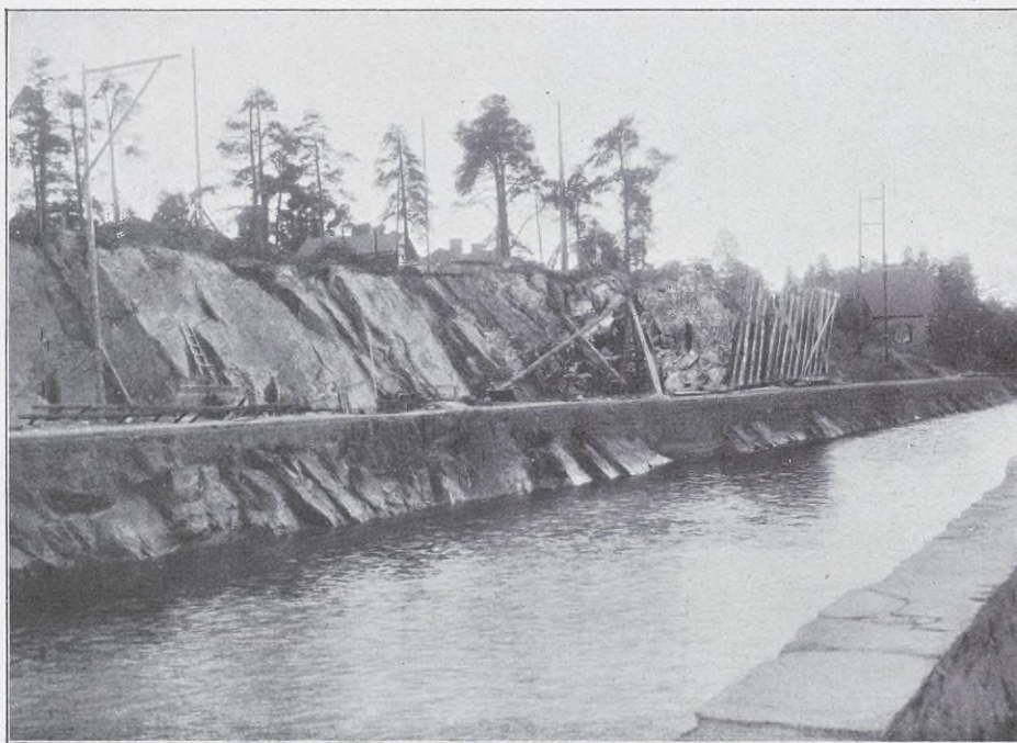
Fig. 16. Sidoschakt å östra sidan af bergkanalen.
