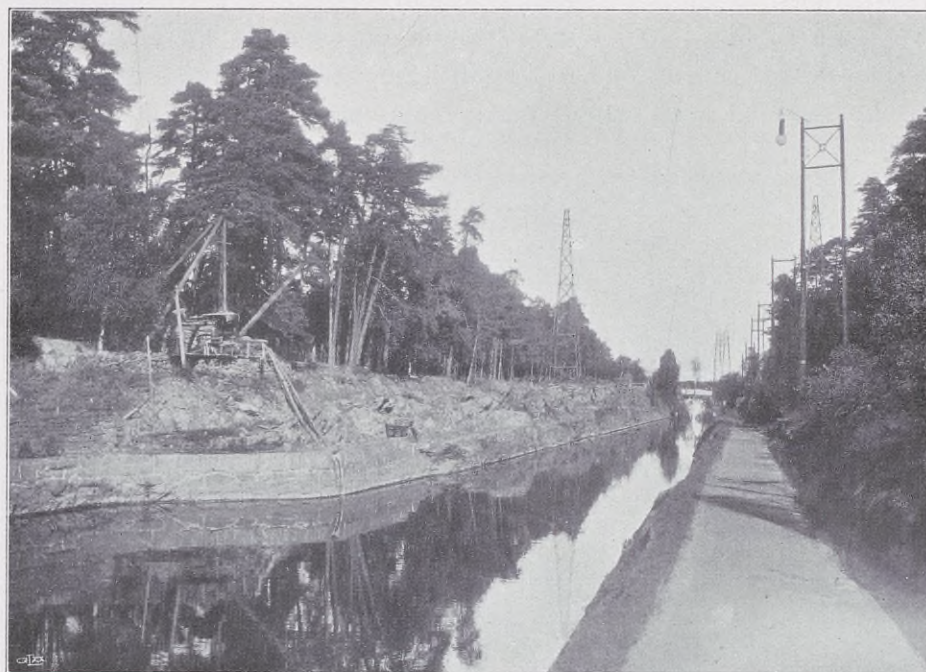
Fig. 17. Sidoschakt å västra sidan af bergkanalen.
