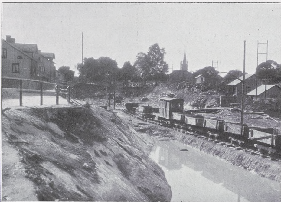
Fig. 14. Schakt i norra ändan af Österlånggatan i Trollhättan.
