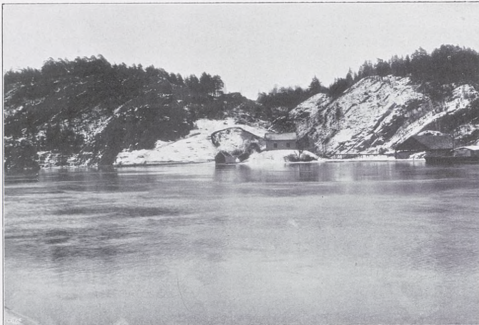
Fig. 19. Platsen för den nya slustrappan vid arbetenas påbörjande.
