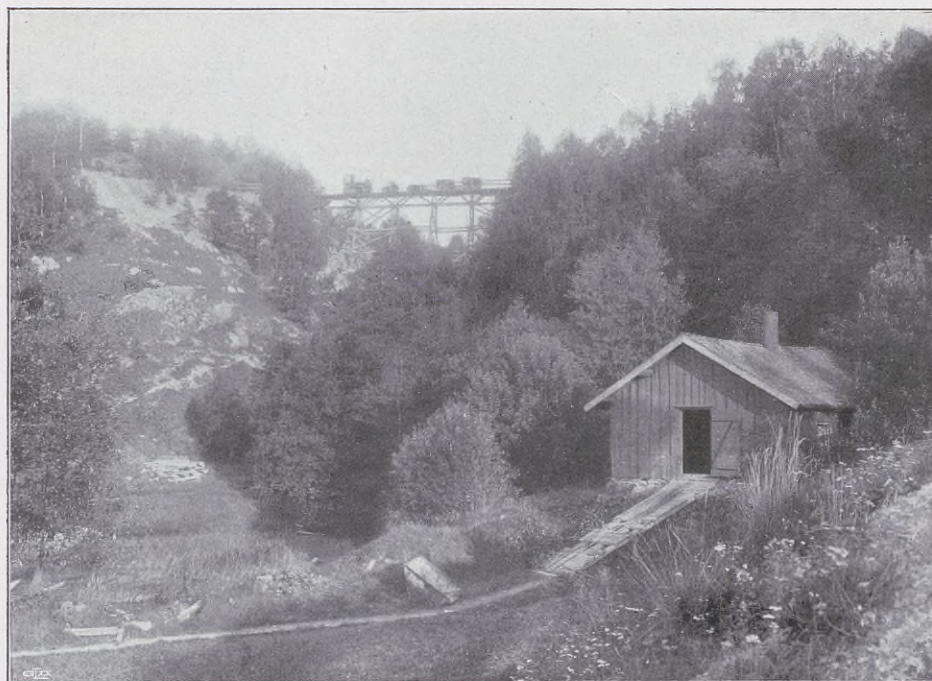
Fig. 24. Högbana för transport från öfre schaktet vid slusstrappan.
