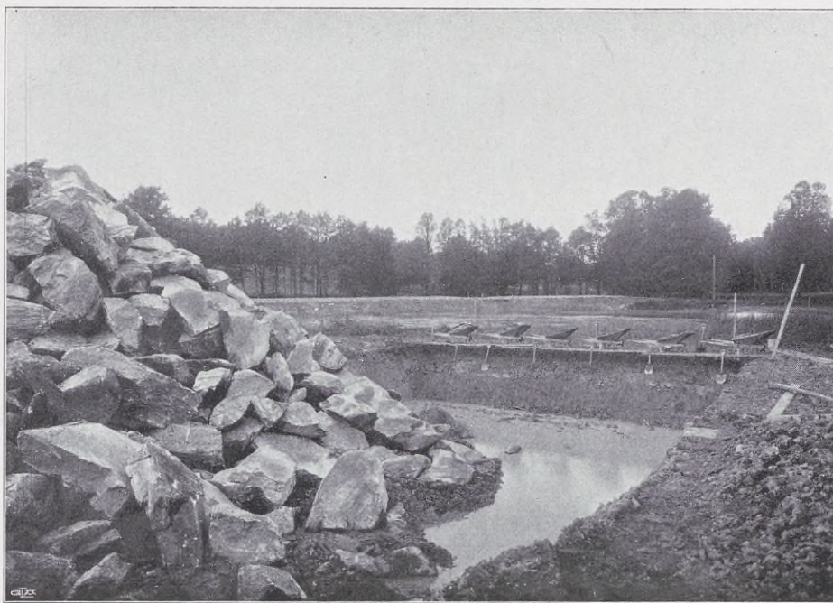
Fig. 30. Utfyllning för östra dammen vid Brinkebergskulle
