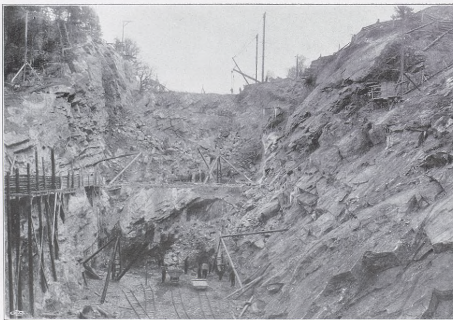
Fig. 20. Bergschakt för slustrappan, sedt söderifrån.
