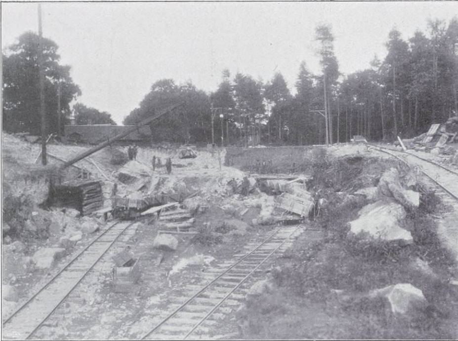
Fig. 22. Öfre schakt för slusstrappan, söderifrån.
