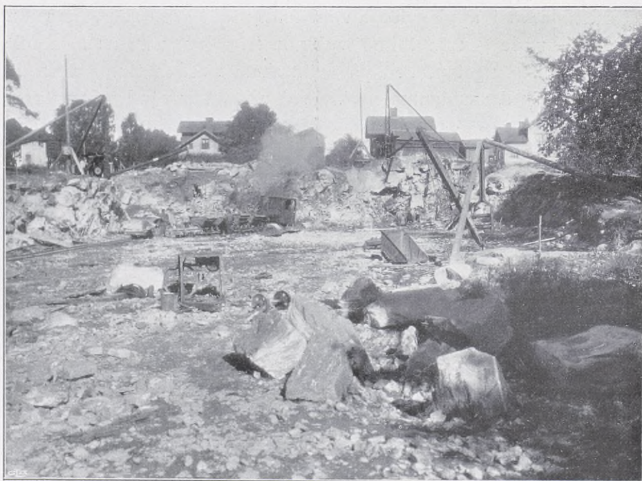
Fig. 15. Schakt i södra ändan af Österlånggatan i Trollhättan.
