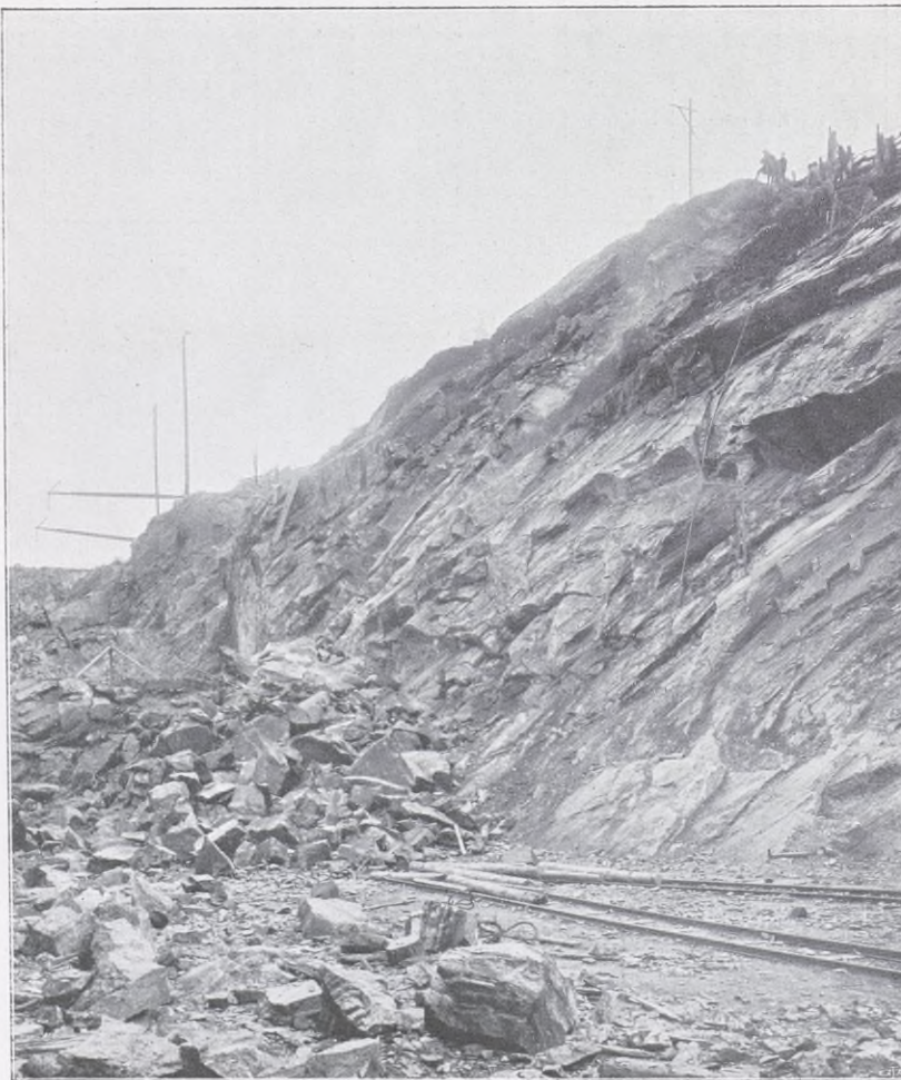
Fig. 26. Bergschakt vid nedre ändan af slustrappan.
