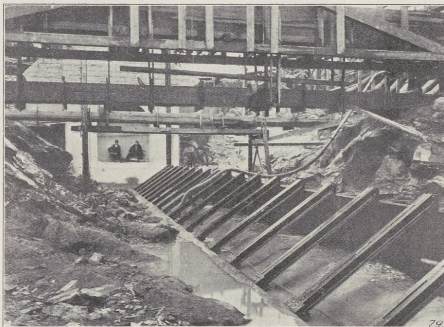
Fig. 42. Tröskeln för afstängningsanordning vid Karls graf. April 1911.
