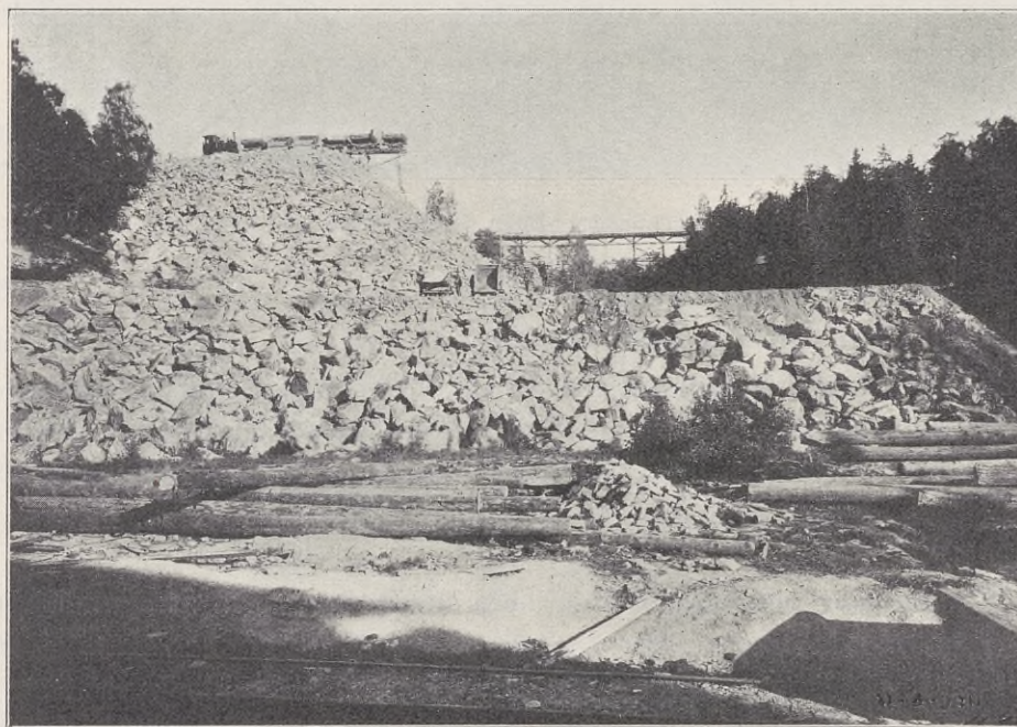
Fig. 41. Stentipp vid Holmen nedom slustrappan, afsedd som upplag för makadamtillverkning. Aug. 1911.
