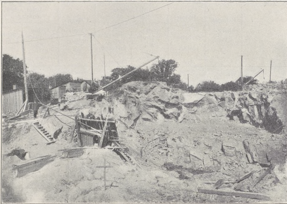
Fig. 29. Schakt för sluss vid Brinkebergskulle, sedt söderifrån. Juli 1911.
