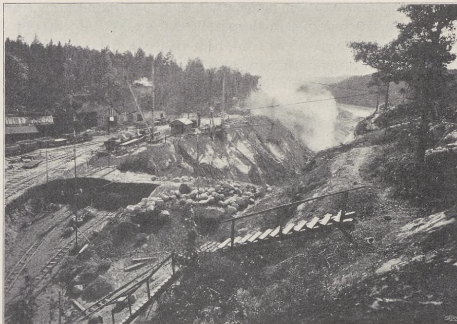
Fig. 40. Schakt för slustrappan, sedt uppifrån. Aug. 1911.
