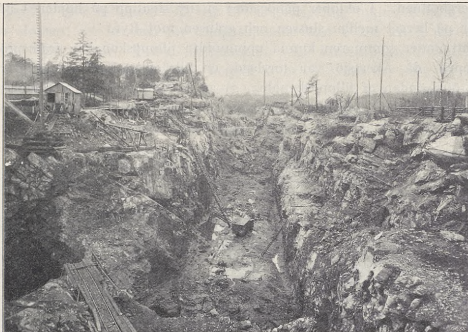
Fig. 36. Schakt för sluss N:o 2, sedt från öster. Nov. 1911.
