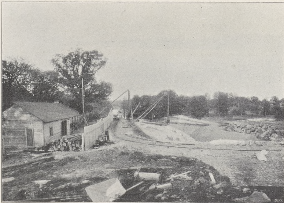
Fig. 30. Schakt för sluss vid Brinkebergskulle. Okt, 1911.
