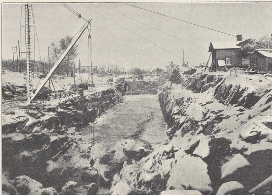
Fig. 34. Schakt i Österlånggatan vid Trollhättan, sedt söderifrån. Nov. 1911.
