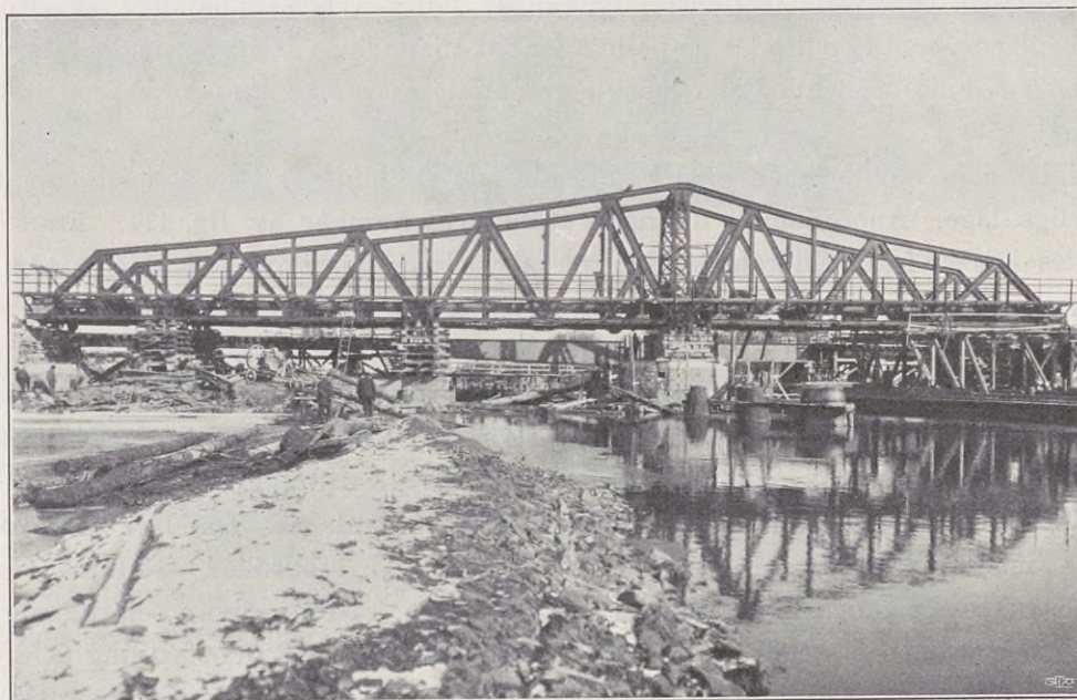
Fig. 112. Bergslagsbanans bro. Svängspannet sänkes. 28 febr. 1913.
