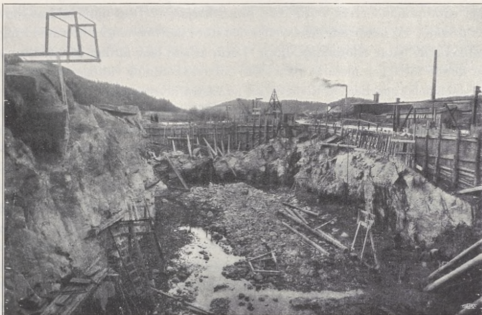
Fig. 83. Bergshakt bakom fångdamm vid Röda berget, april 1913.
