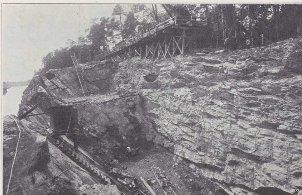
Fig. 73. Bergsprängning nedom Olidan, aug. 1913.
