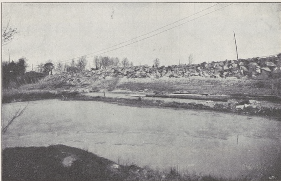
Fig. 120. Östra avstängningsdammen vid Brinkebergskulle, mars 1913.
