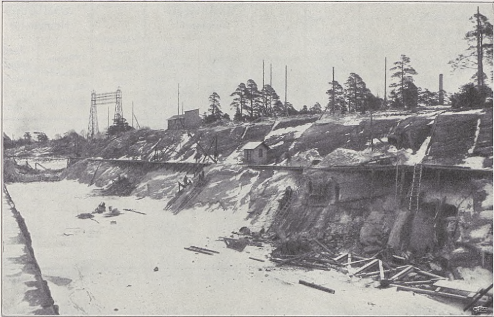
Fig. 74. Bergsprängningsarbeten i bergkanalen framför Nydqvist & Holms verkstäder, jan. 1914.
