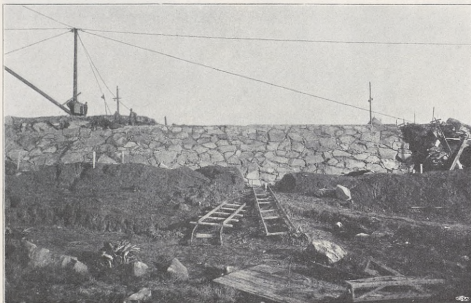
Fig. 121. Glacisläggning å östra avstängningsdammen vid Brinkebergskulle, nov. 1913.
