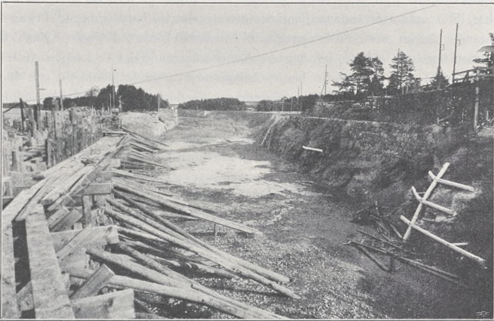
Fig. 68. Södra delen av Stallbackakanalen i färdigt skick före vattnets insläppande.
