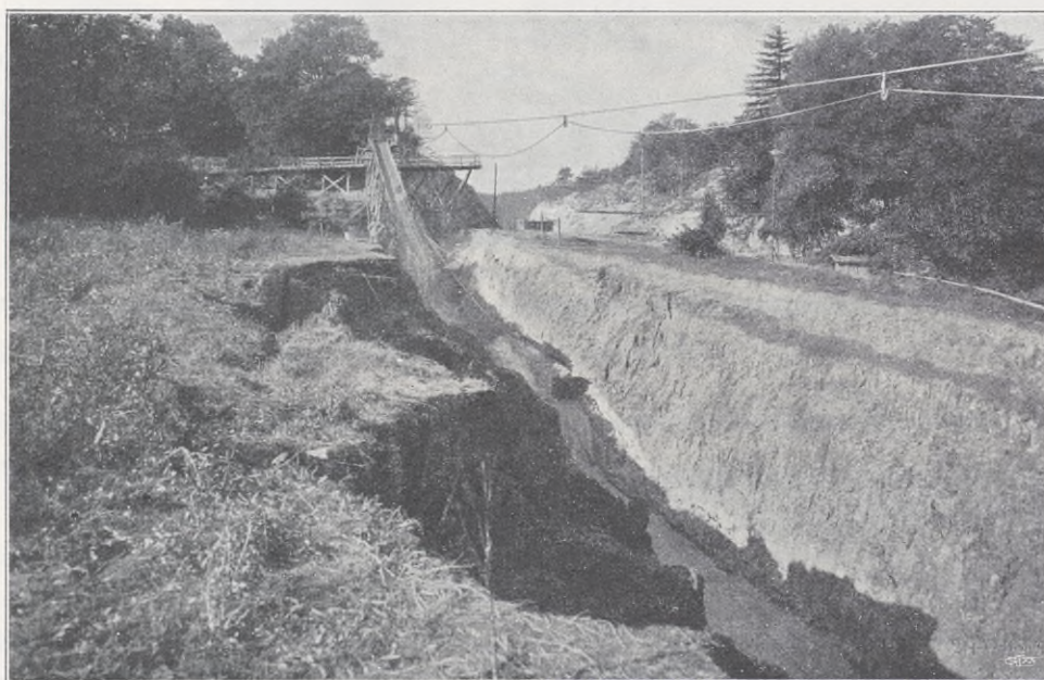
Fig. 52. Muddring med släpskopa i Höljan ovanför nya slusstrappan.
