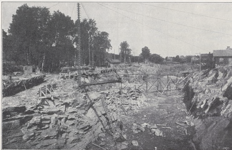
Fig. 71. Norra schaktet i Österlånggatan vid Trollhättan, aug. 1913.
