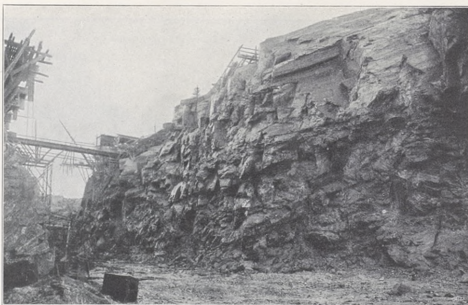
Fig. 60. Södra bergväggen i sluss n:r 2, sedd från väster.
