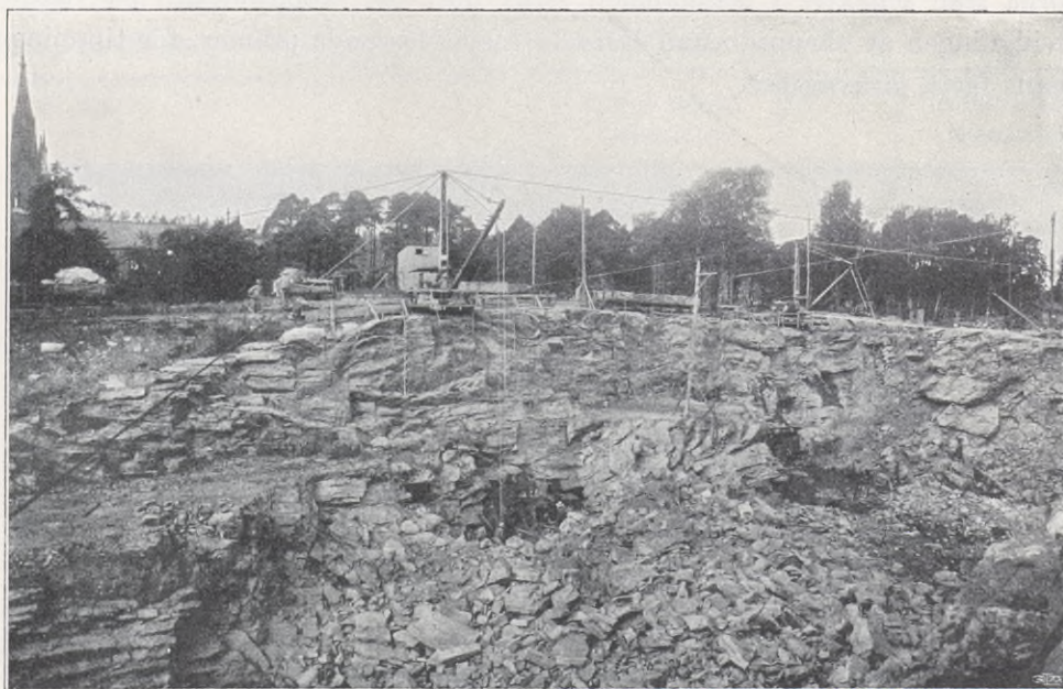
Fig. 72. Södra schaktet i Österlånggatan vid Trollhättan, aug. 1913.
