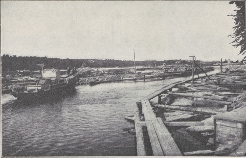
Fig. 124. Ledverk och fångdamm vid Nordkap, aug. 1913.
