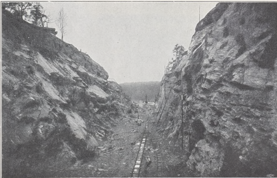
Fig. 77. Bergschakt för slusstrappan, uppifrån, april 1913.
