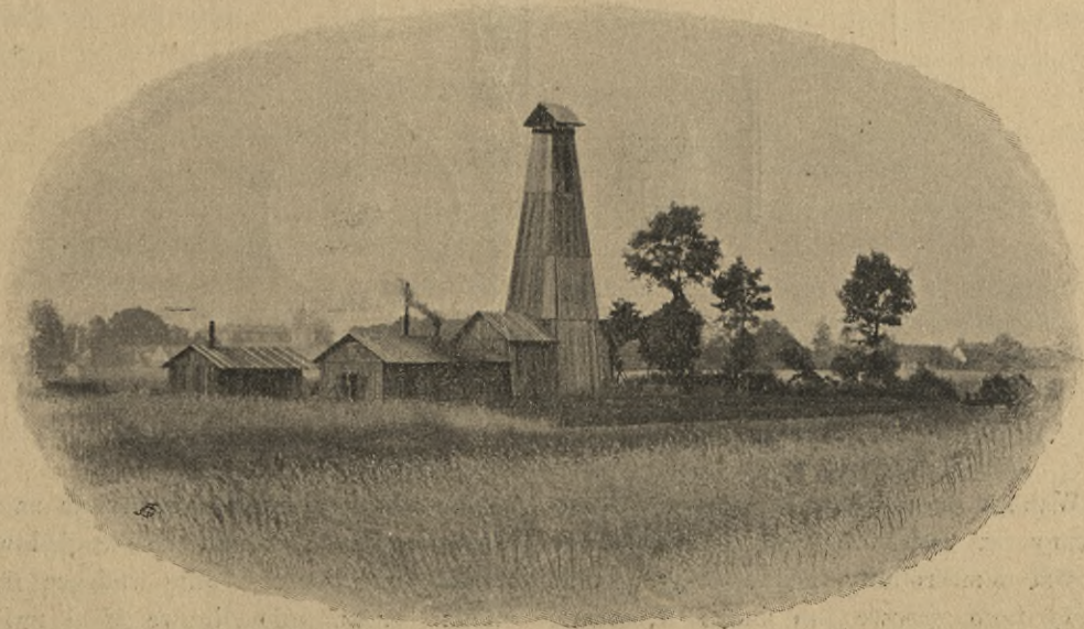
Widok wieży wiertniczej i zabudowań.
