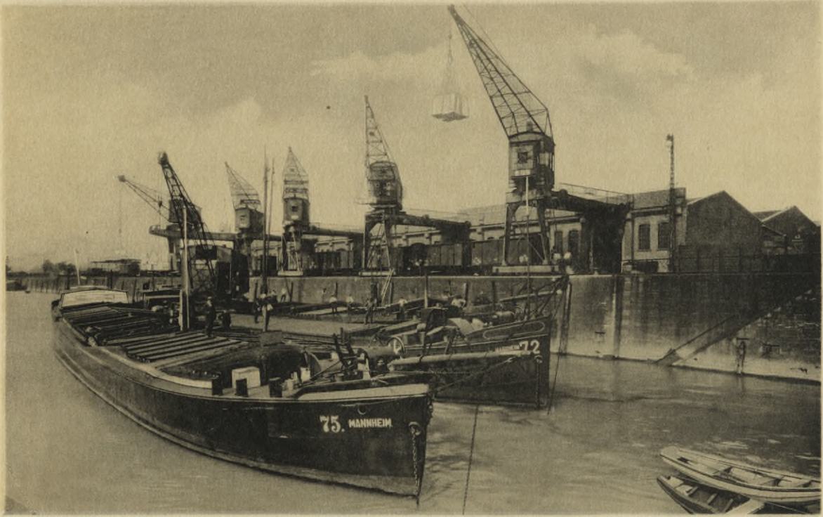
Werfthalle III der Mannheimer Dampfschleppschiffahrts-Gesellschaft im Rheinhafen zu Mannheim.
