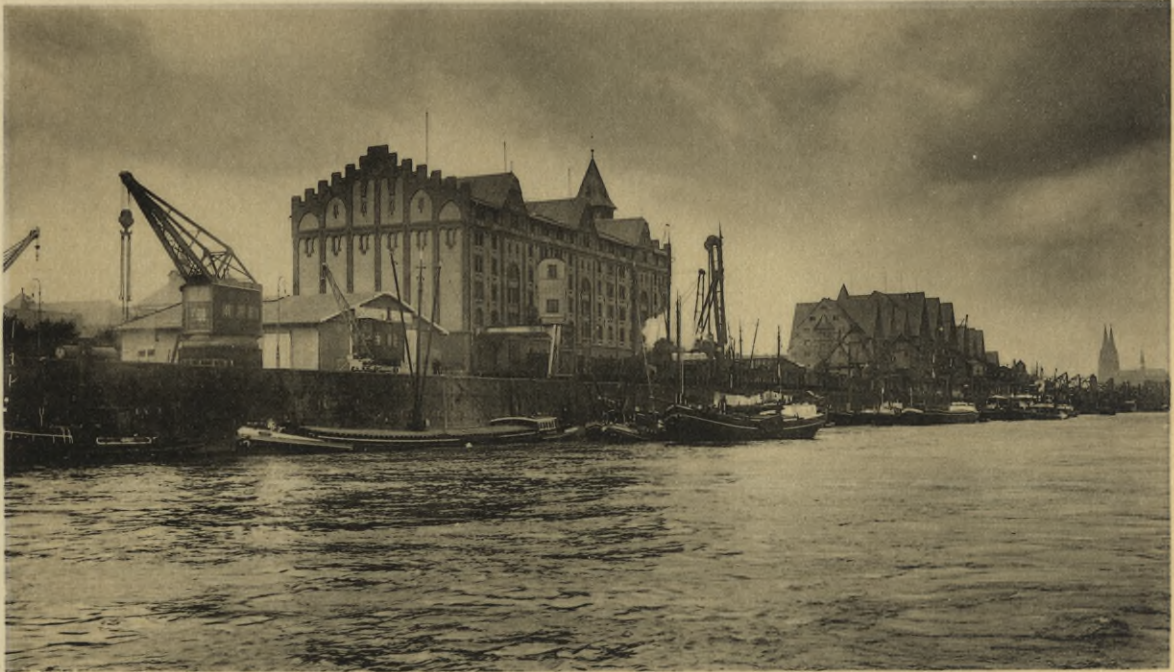
Speicheranlagen in Cöln. Gesamtansicht.
