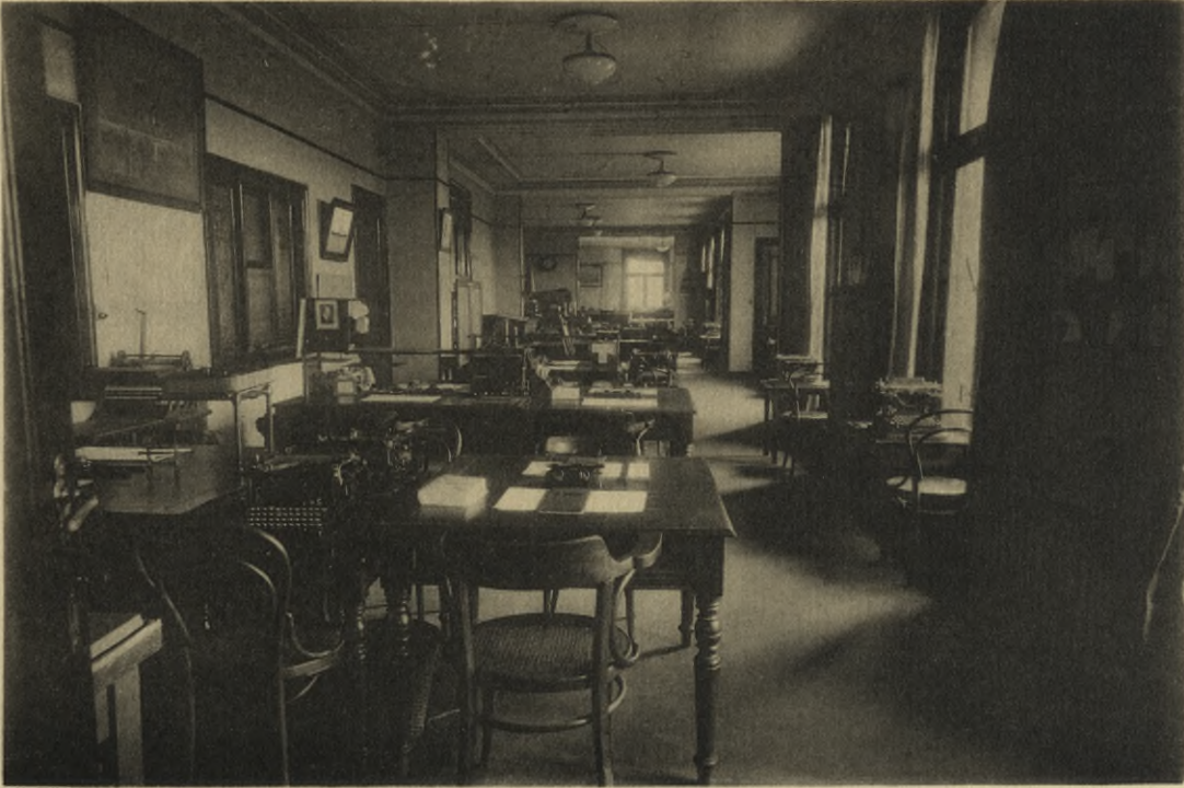
Antwerpen. Innenansicht aus dem Verwaltungsgebäude.
