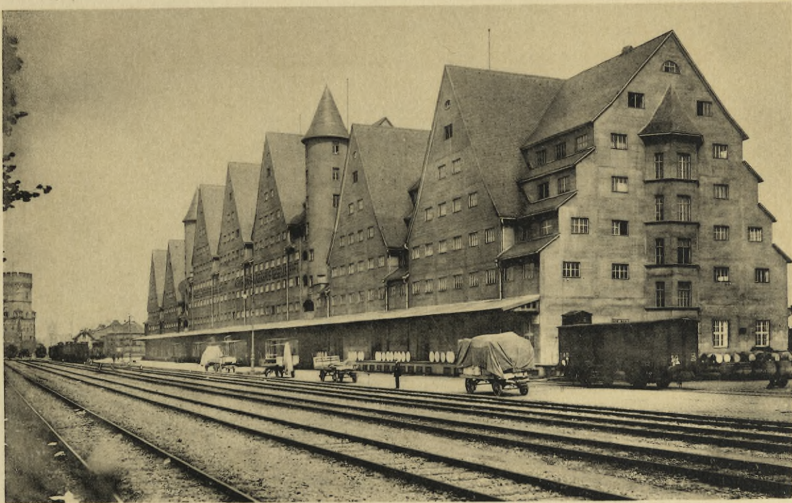
Speicheranlage am Agrippinaufer in Cöln von der Landseite.
