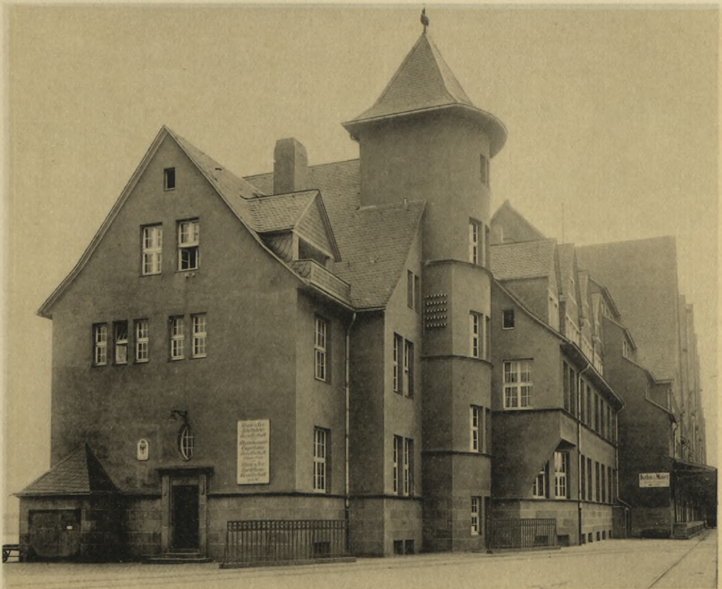
Verwaltungsgebäude in Cöln.
