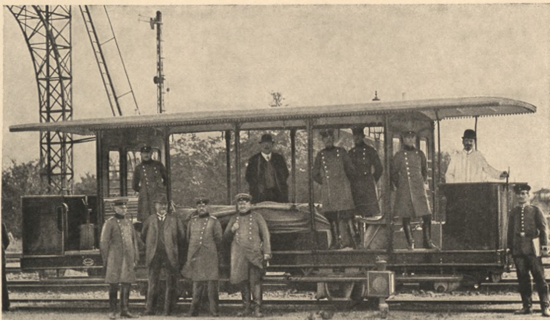
20pferdiger Daimler-Triebwagen für Brasilien auf der Versuchsstrecke der Militär-Eisenbahn.
