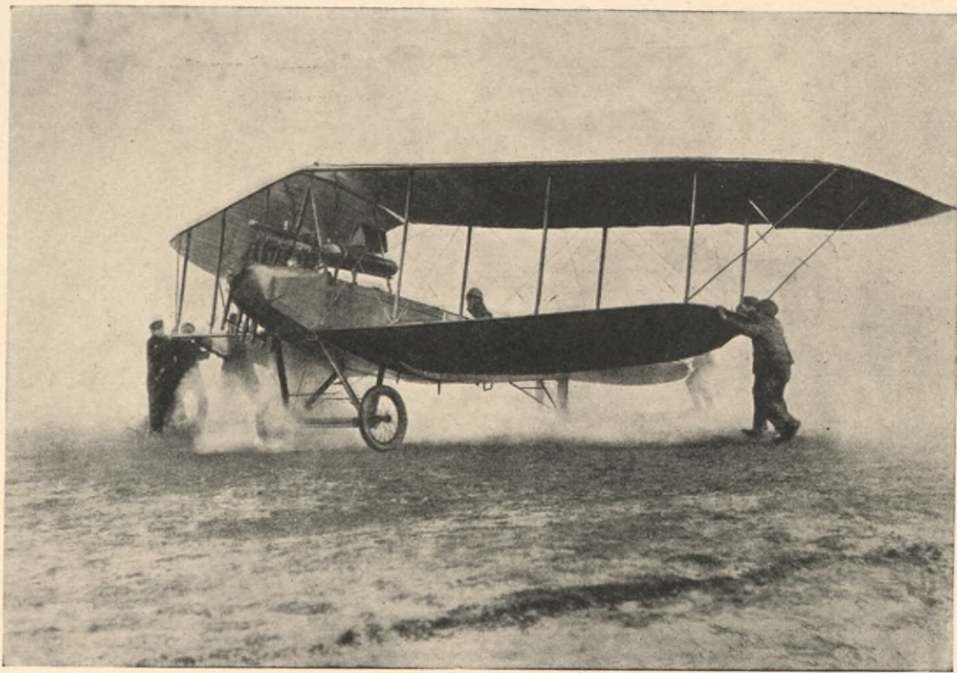
1913: Pfeil-Doppeldecker mit 100pferdigem Sechszylinder-Mercedes-Flugmotor.
