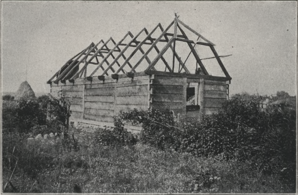
Abb. 19. Dachstuhl eines Hauses im Kreise Sochatschew.
