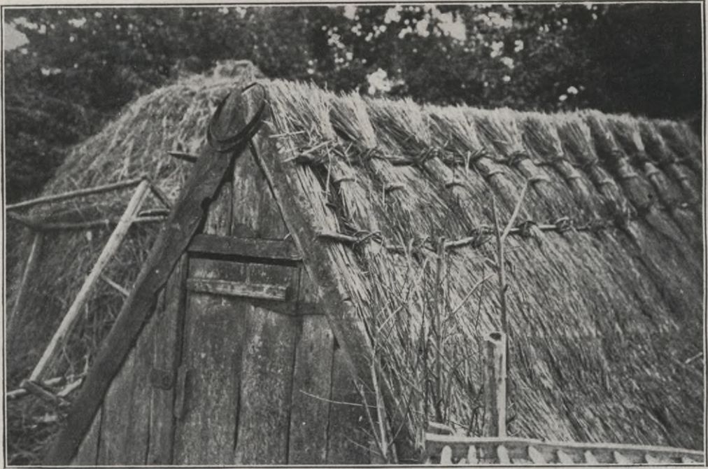
Abb. 26. Dachdeckung eines Hauses im Kreise Wlozlawet
