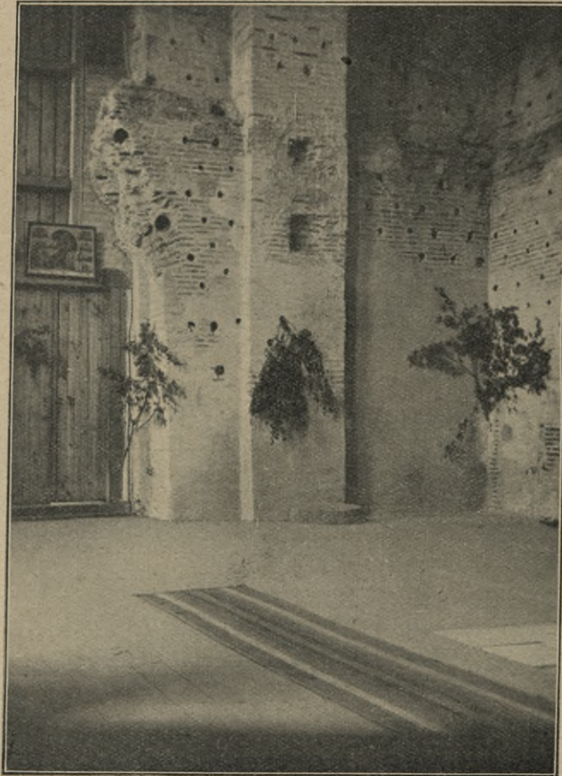
Rys. 237. Głośniki w cerkwi Kołożańskiej pod Grodnem. (amat. fot. p. K.).
