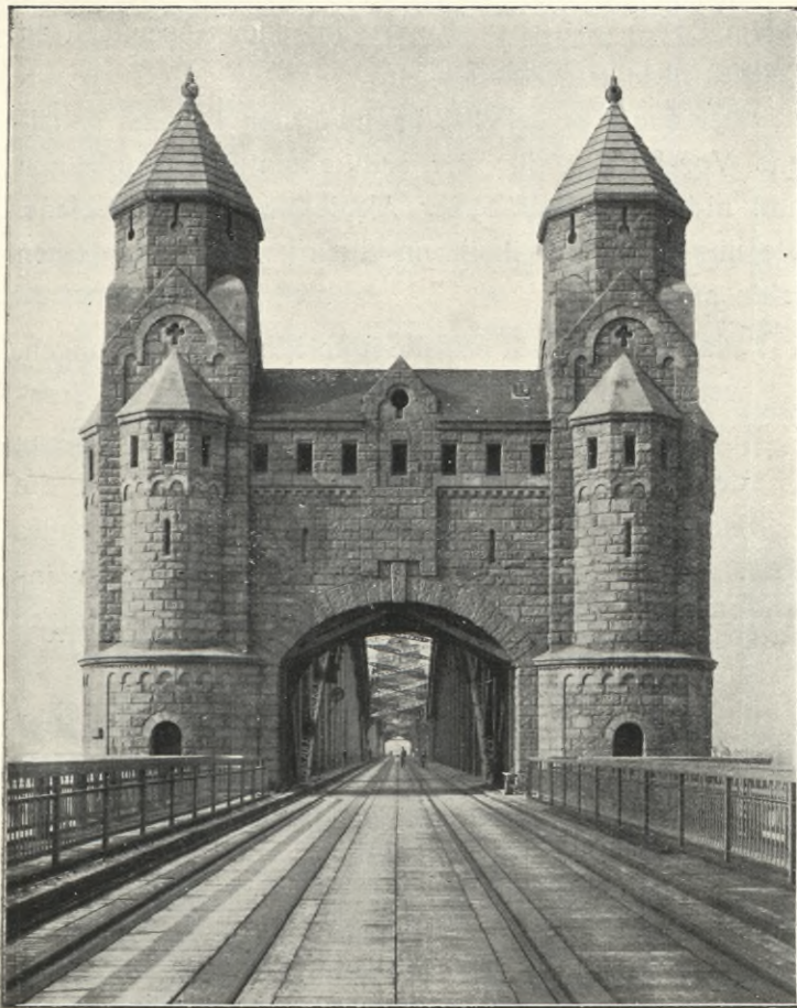
Turmaufbau des Pfeilers VI.
