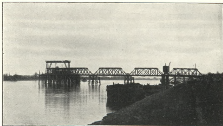
Transportsteg für die Fundierung der Strompfeiler.
