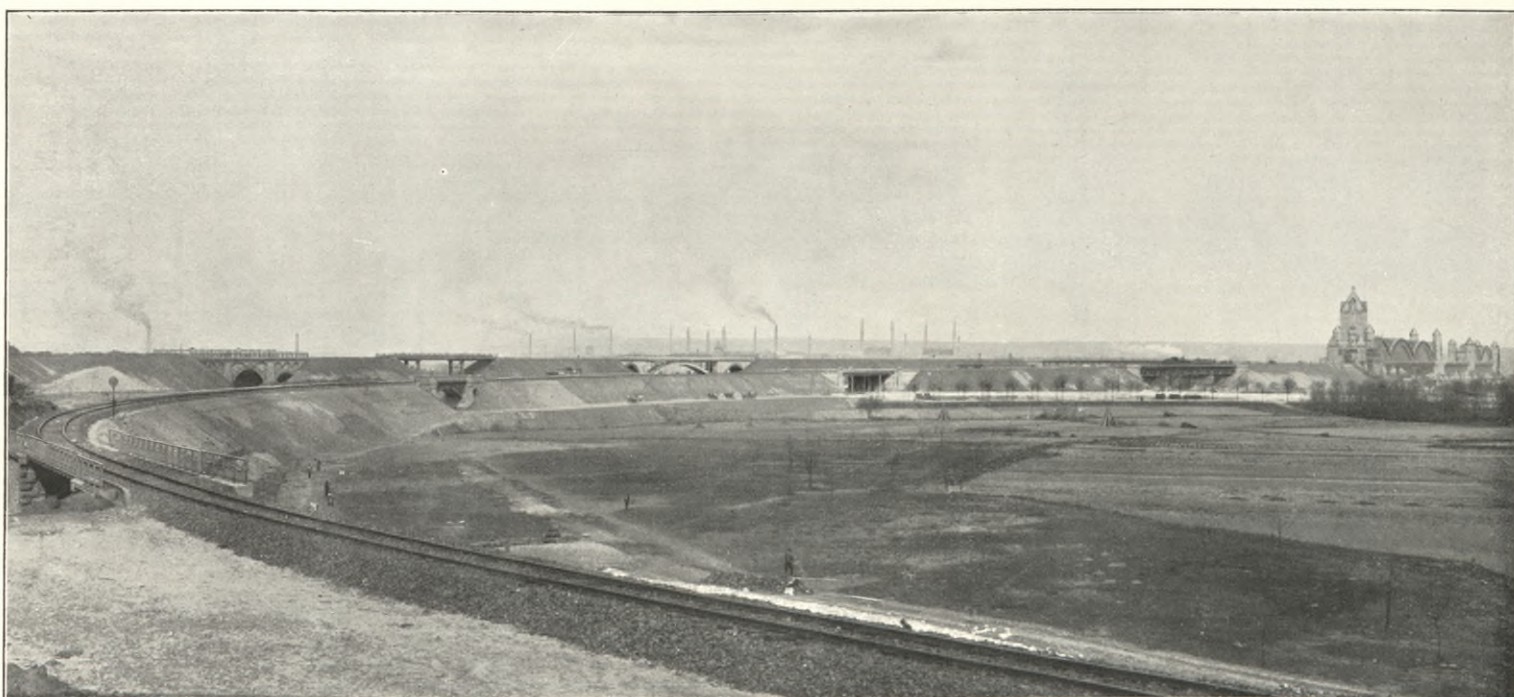
Linksrheinische Brückenrampe von Mainz aus.
