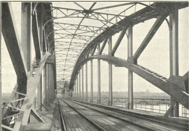
Innenansicht der eisernen Überbauten.
