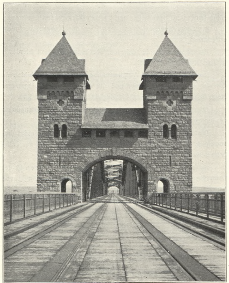
Turmaufbau des Pfeilers XII.
